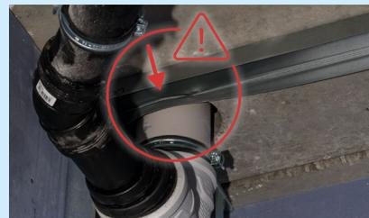
**Figura 41:** Evitar el contacto con perfiles
