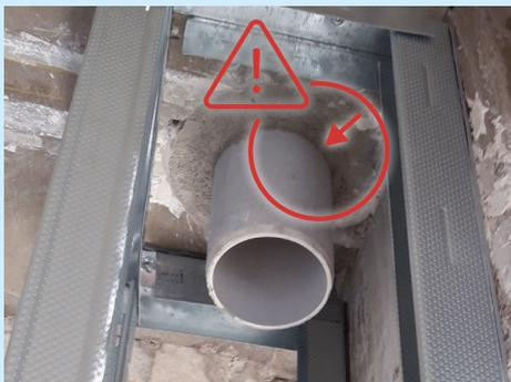
Figura 20: Sonido transmitido por estructuras olvidado desacoplamiento
