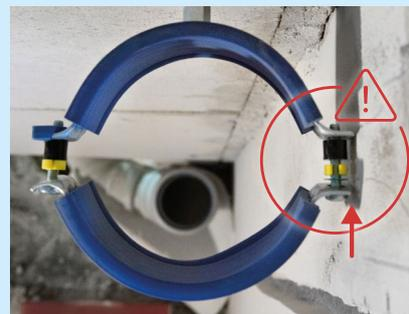
**Figura 40:** Alineación correcta de los soportes de tubería
