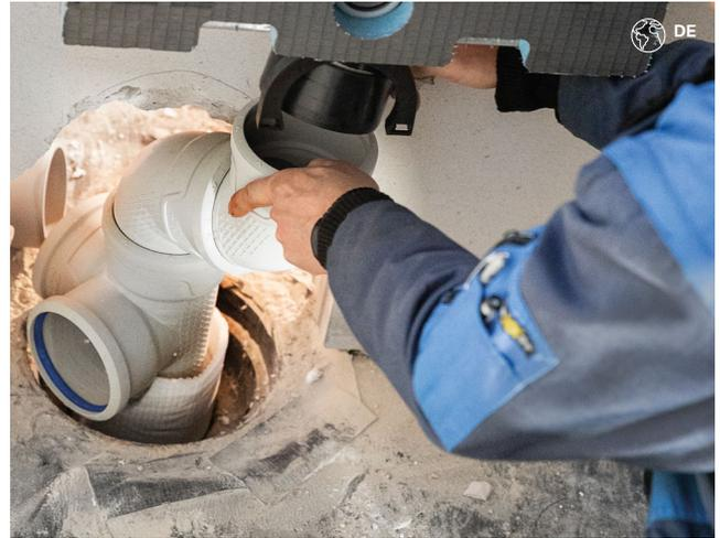
**Figura 42:** Configuración de un sistema de alcantarillado para una losa de piso.
