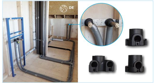
Figura 36: Conjuntos de aislamiento acústico
