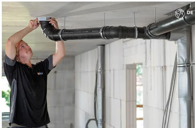
**Figura 39:** Tubería de aguas residuales con aislamiento acústico
