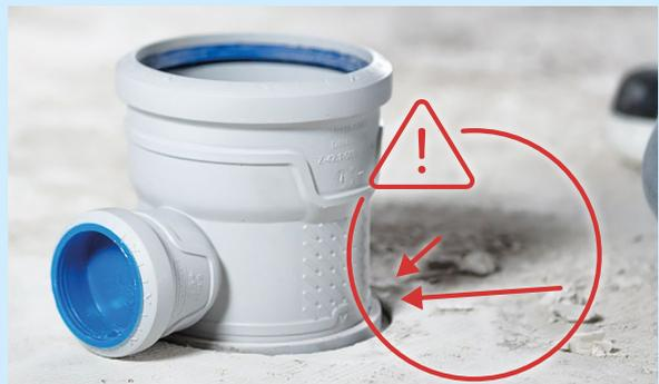
Figura 21: Los escombros de la construcción como un puente de sonido
