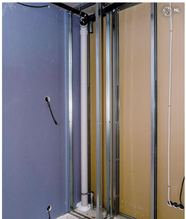
Figura 12: Paredes de cartón yeso con fijación mediante escuadras a techo y suelo
