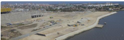
**PROTECCIÓN DE ORILLAS** y recuperación de áreas planas con geosintéticos.
