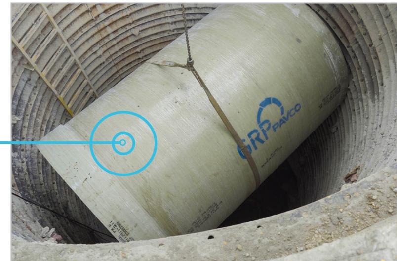
Dicho sistema opera de la siguiente manera: se excavan secciones de aproximadamente 90 cm de longitud, se ensambla una estructura en lámina conformando un túnel y posteriormente se instala dentro de éste **la tubería GRP Pavco de 2 metros de diámetro**.
