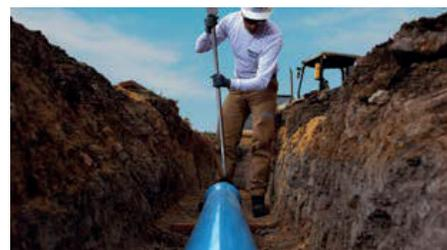
Para los accesorios de H.D. con junta restringida, se tienen las mismas recomendaciones de limpieza, lubricación y preparación de los espigos.
