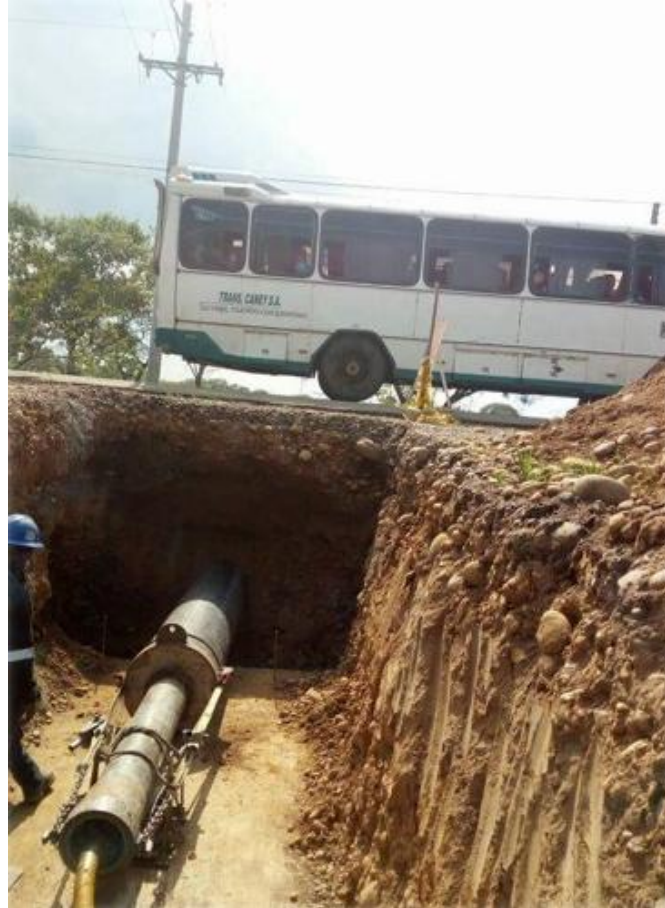
Figura 39 Reporte del proyecto de instalación de tubería de alcantarillado mediante el método Pipe Ramming en Barranca de Upía. Fuente: (PERFOTÉCNICA, 2023)
