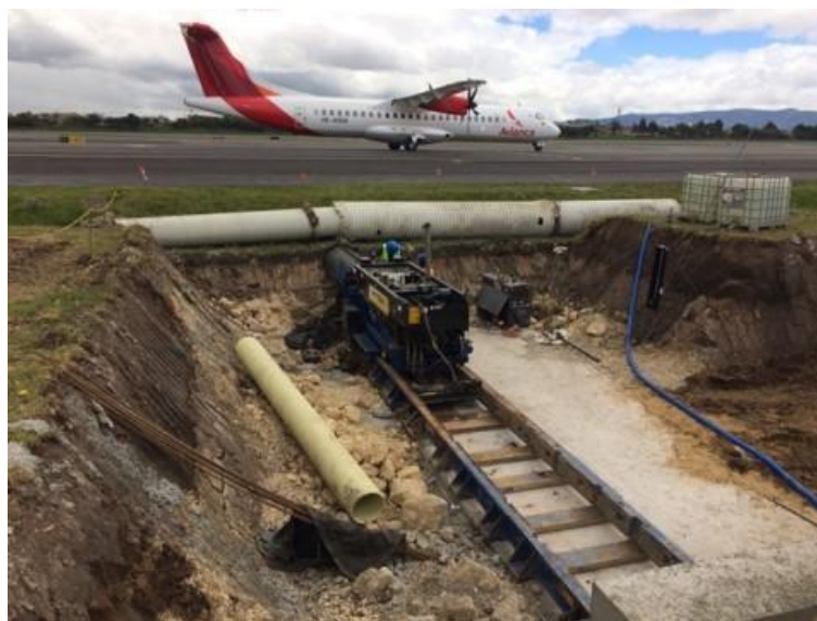
Figura 36 Reporte del proyecto de instalación de tuberías de alcantarillado mediante el método Auger Boring en el Aeropuerto El Dorado. Fuente: (PERFOTÉCNICA, 2023)
