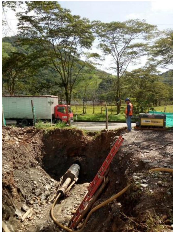
Figura 38 Reporte del proyecto de instalación de tubería de alcantarillado mediante el método Pipe Ramming en Villavicencio. Fuente: (PERFOTÉCNICA, 2023)
