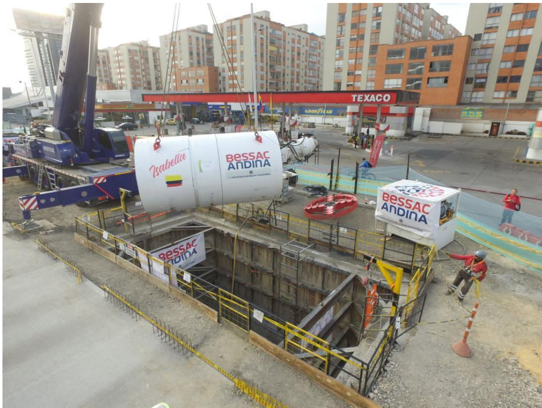
Figura 40 Reporte del proyecto de instalación de tubería de alcantarillado mediante el método Microtunelado en la Avenida 68 de Bogotá. Fuente: (Instituto de Desarrollo Urbano, 2023)
