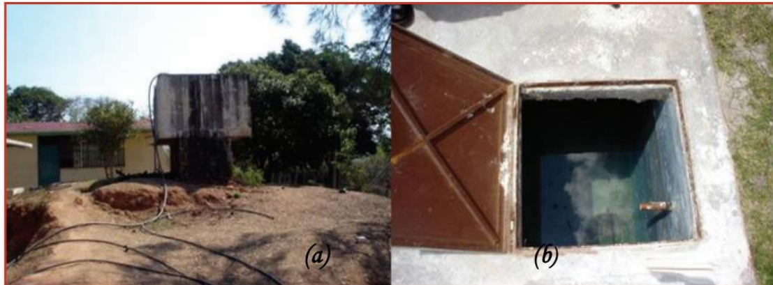
Ilustración 25. tanque construido en concreto
