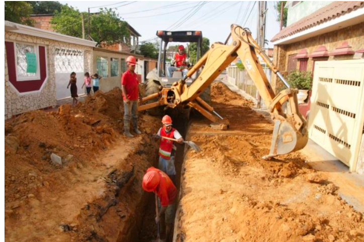
Ilustración 10. Proceso de instalación a cielo abierto. Tomado de: Alarcón, J., & Pacheco, J. (2014).
