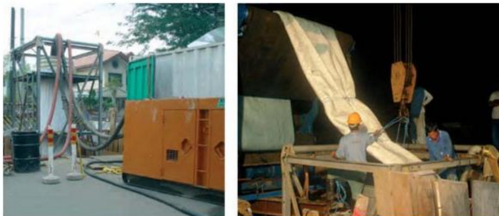
Figura 22. Maquinaria utilizada en el método CIPP
