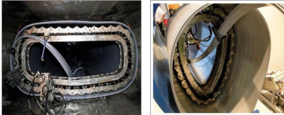
Figura 24. Rehabilitación de tuberías de diferente sección con el método spiral wound lining
