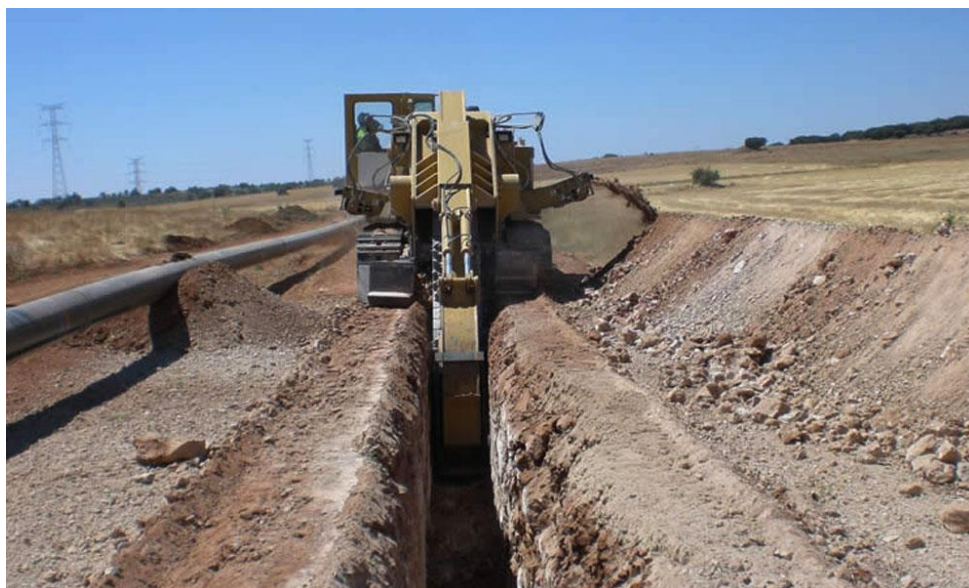
Figura 2. Excavación a zanja abierta.
