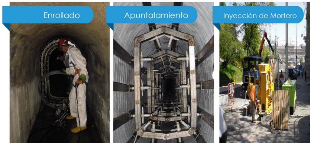
Figura 26. Instalación Spiral Wound
