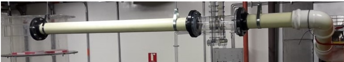
Figura 14. Tubería de alimentación a la cámara de vórtice
