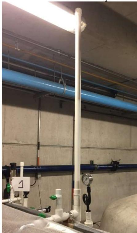
Figura 14: Amortiguador de tubería PVC 1m
