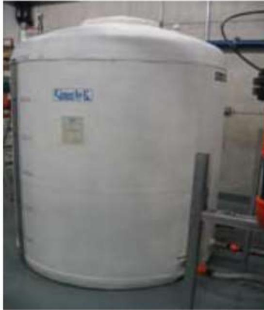
Figura 2: Tanque de Almacenamiento de Agua. (Fonseca, 2009)
