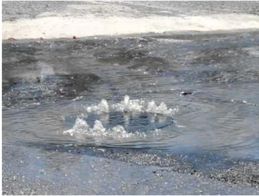
Figura 7: Sobrecarga en los pozos. (LA CALLE Digital, 2012)
