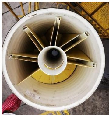
Ilustración 50. Vista aérea del desarenador helicoidal
