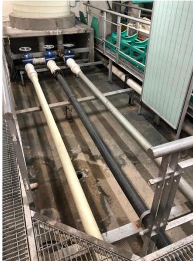
Ilustración 40. Tuberías PVC, laboratorio alcantarillado Uniandes
