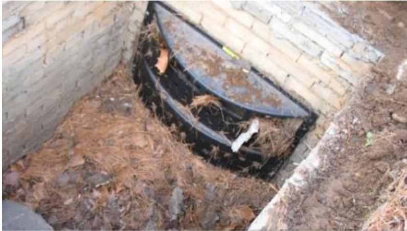
**Ilustración 2. Trash Guard Plus antes de la limpieza**
