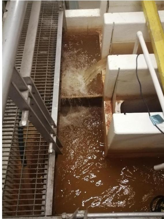
Ilustración 15. Tanque de almacenamiento y alimentación principal.
