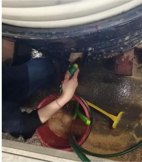
**Ilustración 24. Eliminación manual de la arena**
