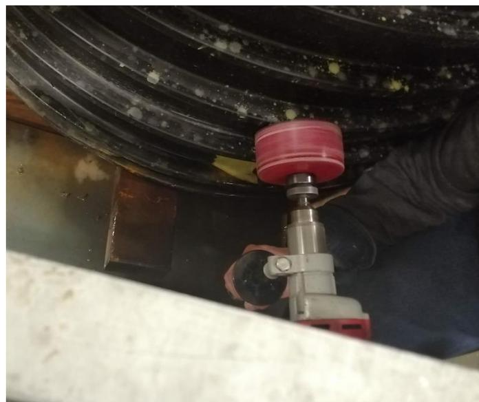
**Ilustración 21. Creación del primer agujero de la cámara**
