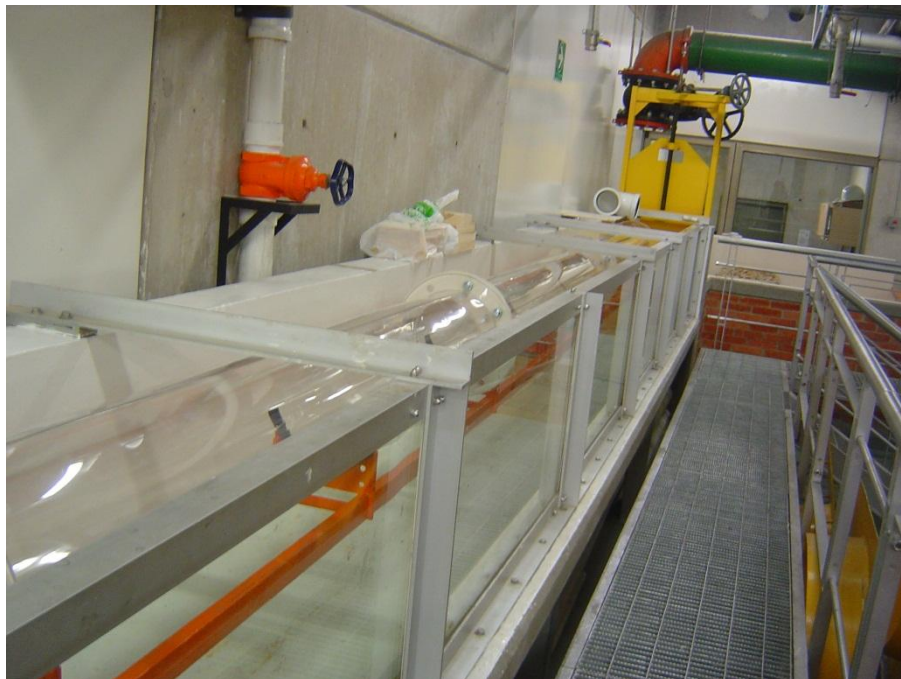
Ilustración 40. Vista aguas abajo de la tubería.
