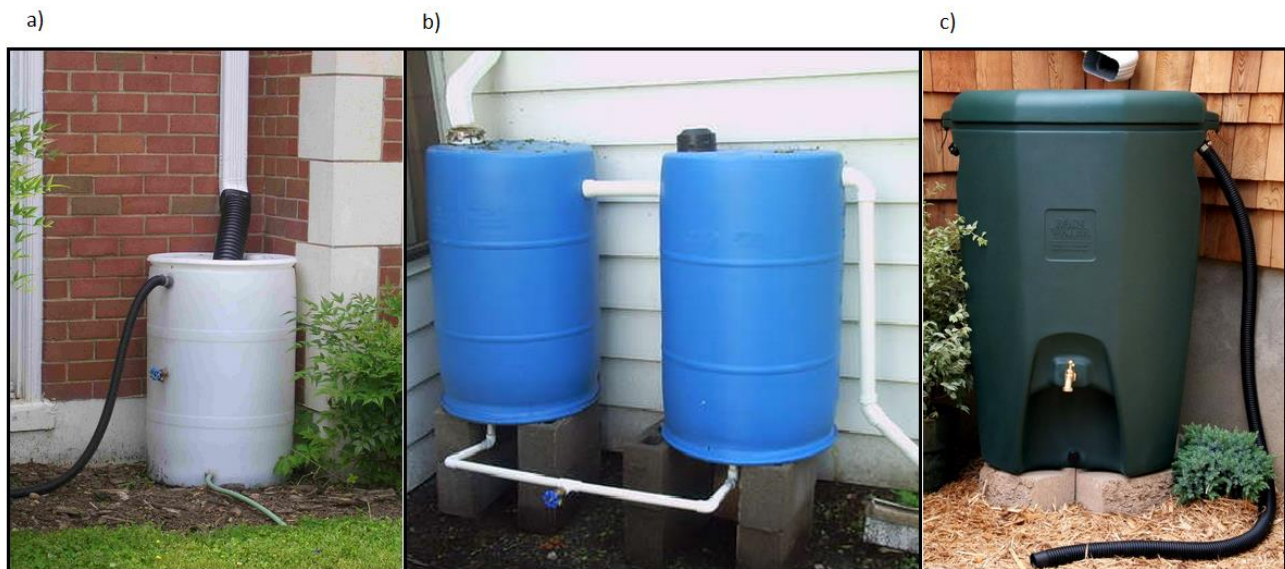
Figura 4-1. Diferentes tipos y configuraciones de sistemas pasivos de almacenamiento de agua lluvia: a) configuración típica de un barril cilíndrico de agua lluvia 11 , b) configuración de un sistema de barriles de agua lluvia puestos en serie 12 y c) configuración típica de un barril no cilíndrico de agua lluvia. 13
