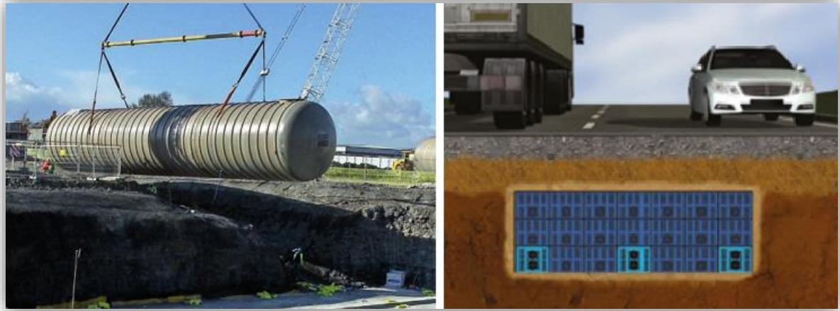
Figura 6. Tipos de Tanques de Tormenta subterráneos prefabricados (izq. Conder Storage Tank, der. Aquacell).
