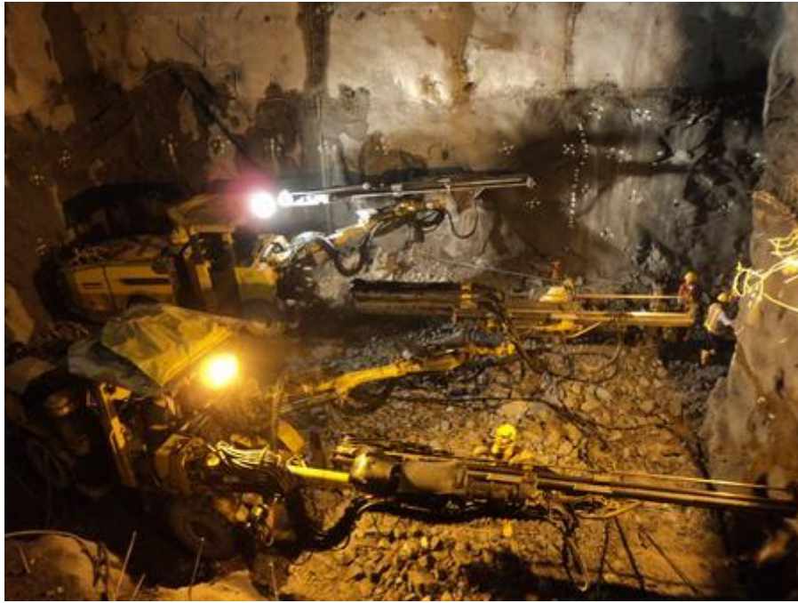
Figura 9. Equipos de perforación de dos brazos, construcción de la Casa de Maquinas.
