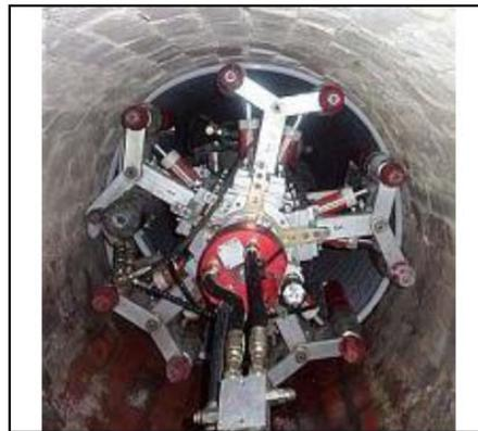
**Figura 4-13 Máquina Rotatoria de Revestimiento en espiral<sup>28</sup>.**
