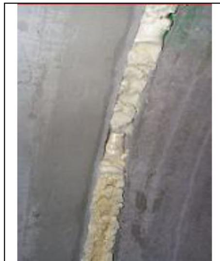
Figura 4-20 Junta sellada químicamente<sup>31</sup>.
