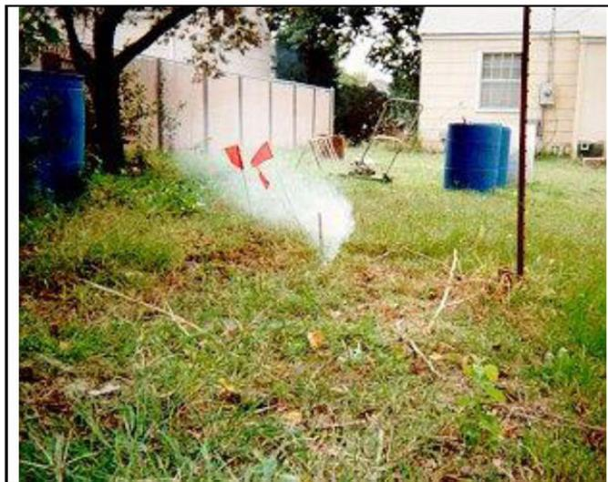
Figura 3-8 Ubicación de puntos de fuga de humo<sup>22</sup>.
