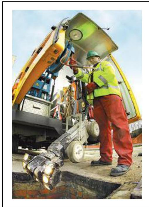
Figura 4-23 Rehabilitación con métodos robóticos<sup>33</sup>.
