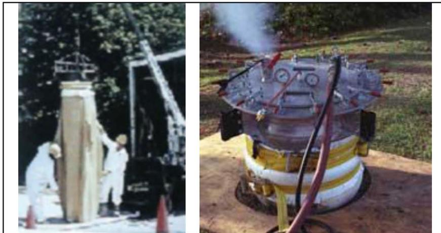
Figura 4-18 Aplicación de bolsas de polietileno para rehabilitación de cámaras de inspección.
