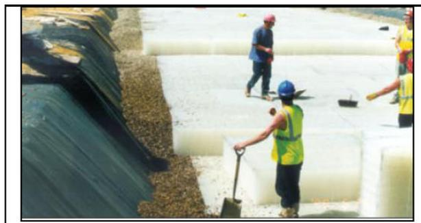
Figura 4-5 Sistema de módulos plásticos<sup>27</sup>.
