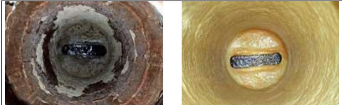
Figura 4-19 Antes y después de instalar la bolsa de polietileno.
