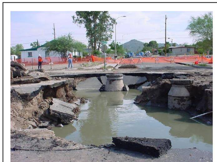
**Figura 2-7** Colapso total de una vía debido al proceso de infiltración<sup>8</sup>.
