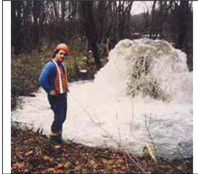
**Figura 2-11 Sobrecarga de un sistema de alcantarillado<sup>12</sup>.**
