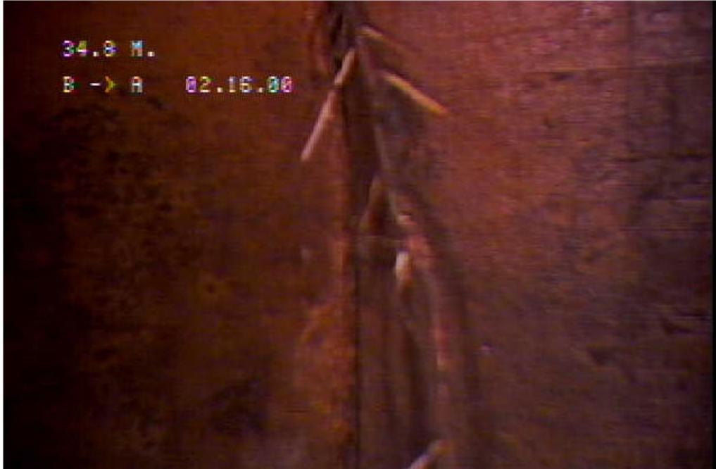
Figura 13. Presencia de Raíces e infiltraciones en una junta.
