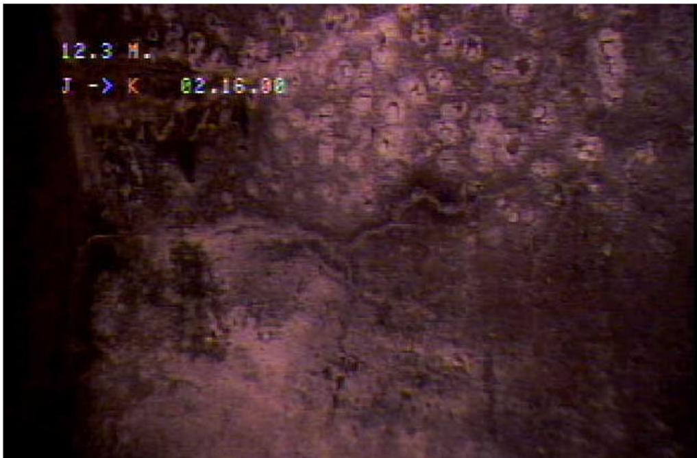
Figura 14. Erosión en la parte superior de la tubería, debido a la acumulación de gases.
