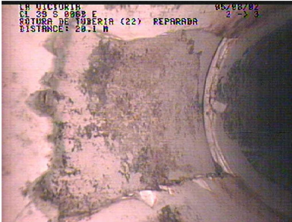
Figura 17. Reparación mal efectuada a una tubería de PVC.
