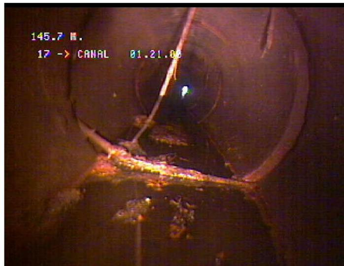
Figura 3. Tubería de Concreto con raíces e infiltraciones.
