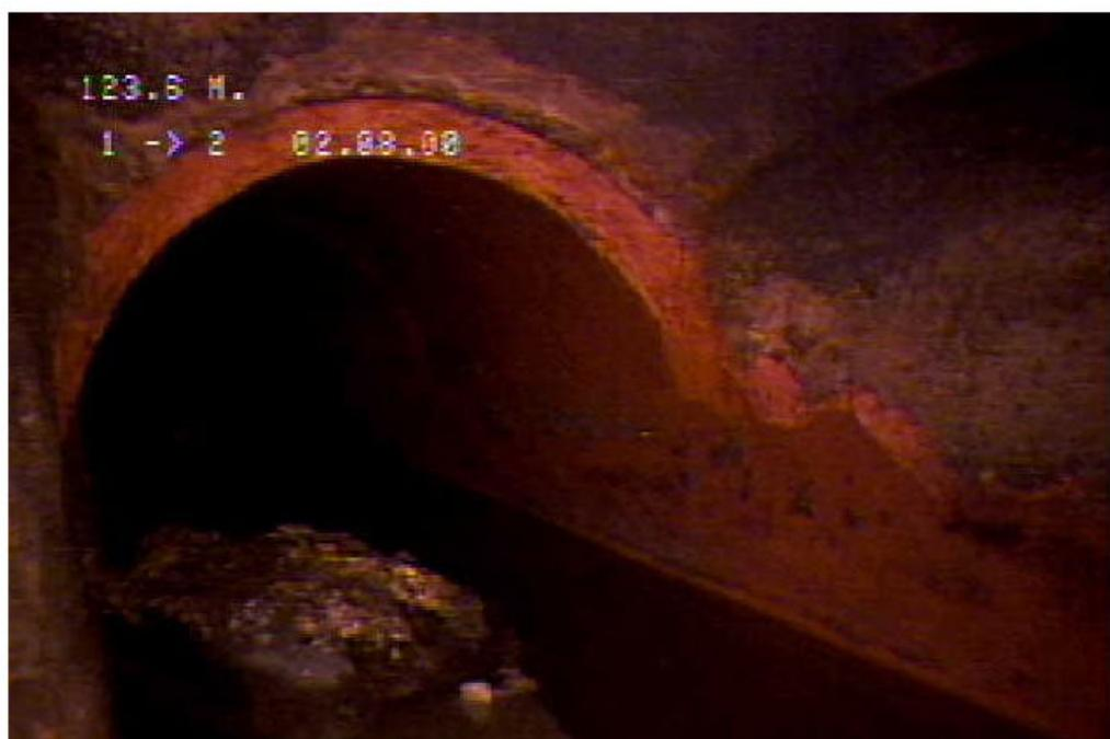
Figura 12. Obstrucción puntual debido a una piedra, no se realizó limpieza previa.
