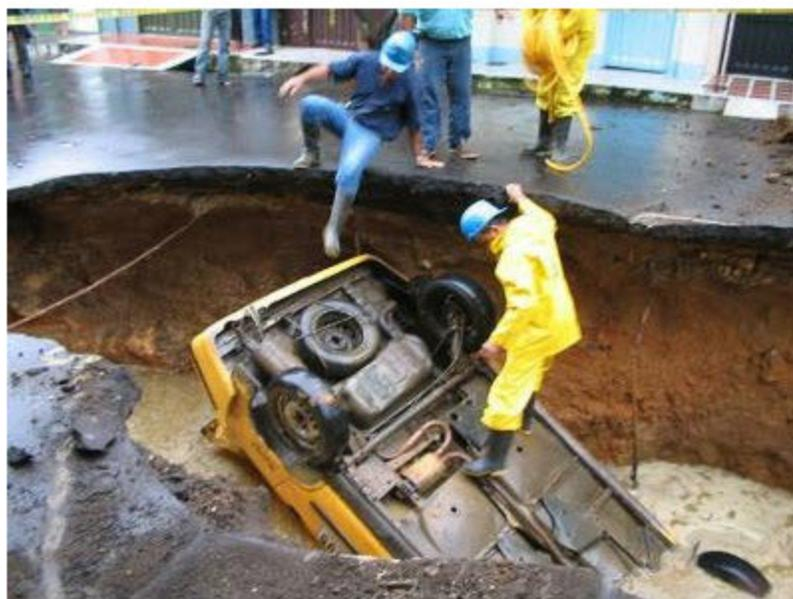
**Figura 4. Hundimiento de una calle debido a la falta de mantenimiento de la red de alcantarillado. Florencia, Caquetá. 02/06/2005.<sup>4</sup>**
