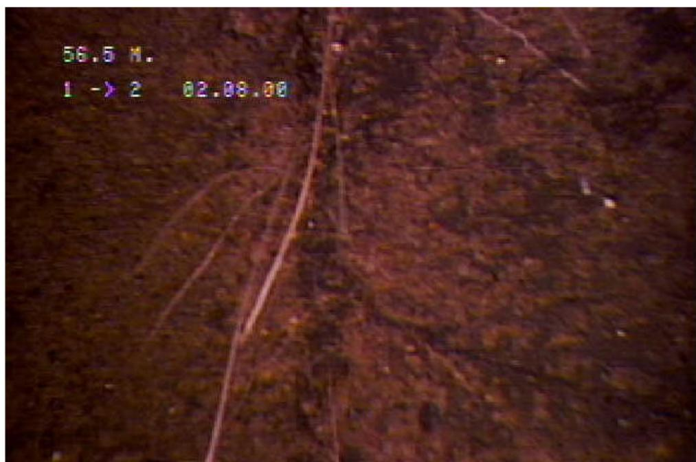
Figura 11. Presencia de Raíces dentro de la tubería.
