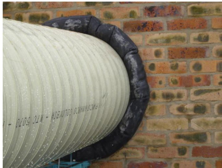
Figura 5.8. Acople de tubería al tanque mediante neumático
