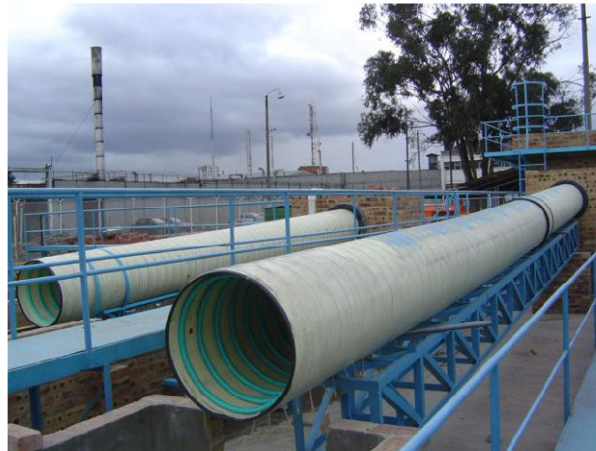
Figura 5.9. Tubería Agua Residual (Izq.) y Tubería Agua Potable (Der.)
