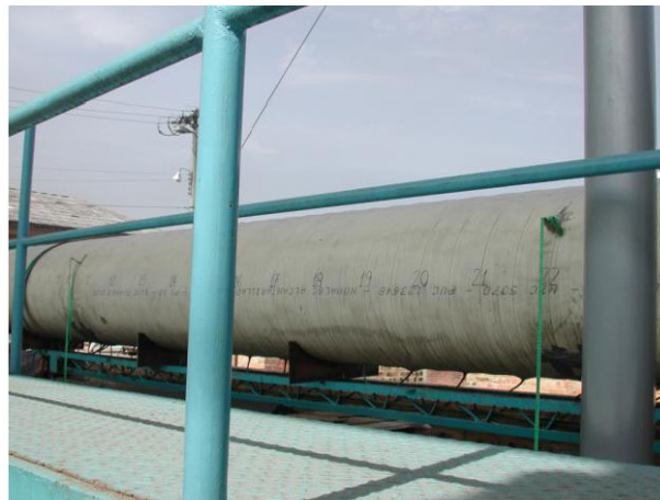
Figura 5.11. Cintas métricas de la tubería para medición de pendiente
