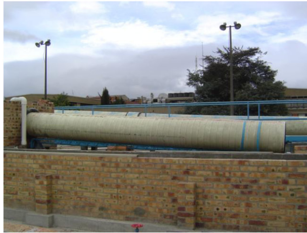
Figura 5.5. – Montaje completo de la tubería de agua residual
