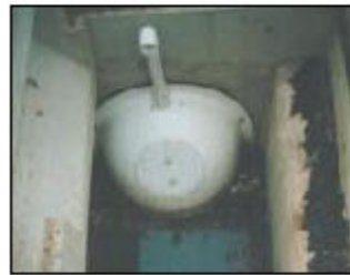
Figura 6-23 Outlet Insert Scout TM. Atrapa sólidos de gran tamaño. 36
