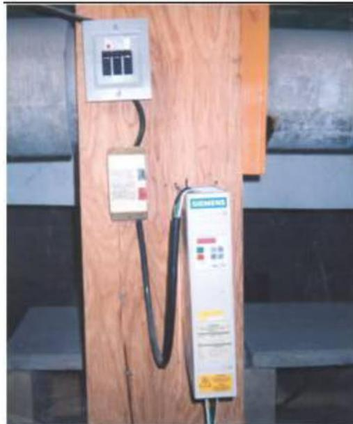
Figura 4-2 Variador electrónico de velocidad
