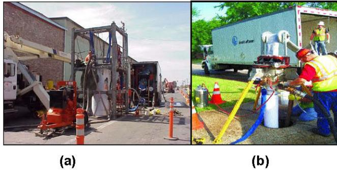
Figura 9 Tuberías curadas en sitio (a) Inversión con agua (b) Halado con cables
