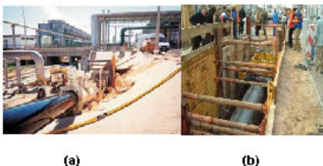
Figura 7 Proceso de reducción química del diámetro (a) Matriz reductora (b) Montaje del proceso
