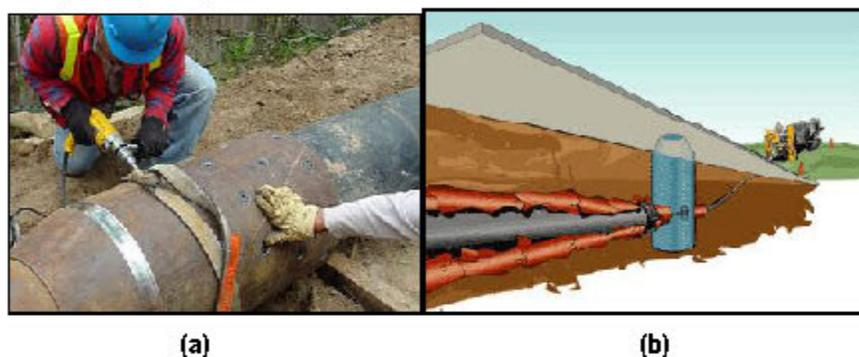
**Figura 3** Reemplazo por rotura de la tubería existente (a) Instalación de la cabeza de rotura (b) Esquema de rompimiento
