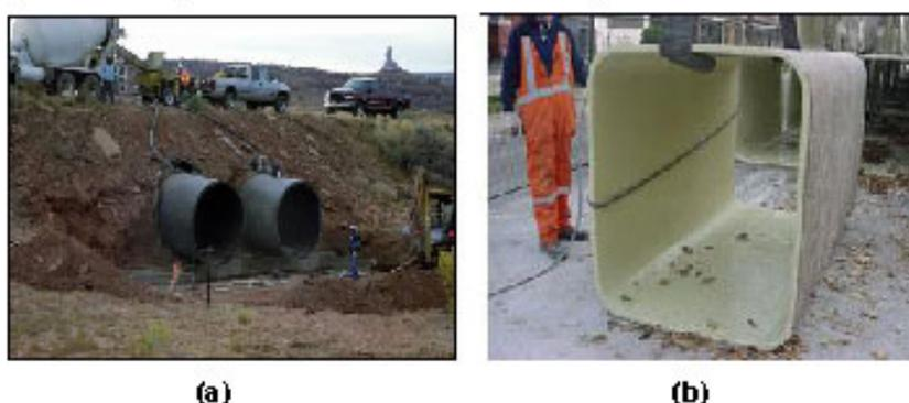
Figura 4 Inserción de revestimiento simple (a) tubería continua (b) segmentada
