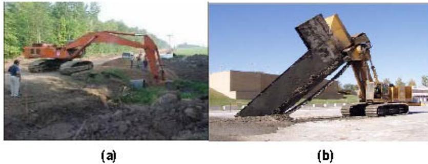
**Figura 2** Reemplazo de tuberías de alcantarillado por medio de zanja (a) zanja abierta (b) zanja estrecha
