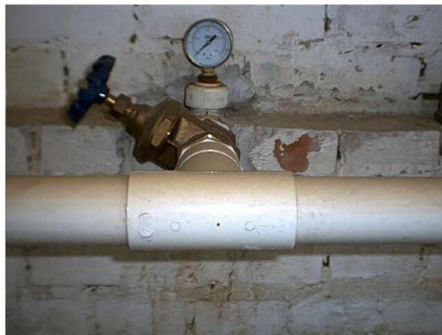
**Figura 5.2: Válvulas y manómetros ubicados en la entrada de cada canal.**
