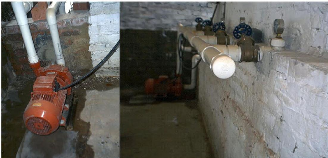
**Figura 5.1: Motobomba y sistema de distribución del circuito de pruebas.**
