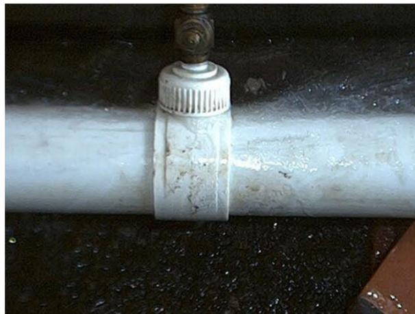
Figura 6.1: Falla en la acometida de una tubería de 3" de diámetro.
