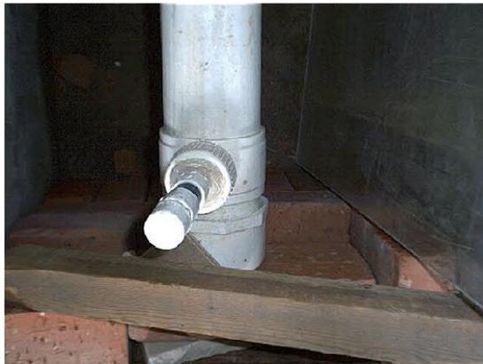
Figura 5.4: Sistema de purga para la evacuación del aire acumulado en la tubería fallada.
