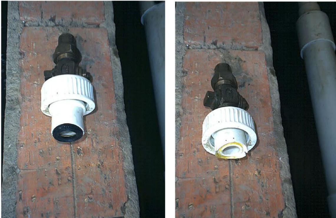
Figura 7.1: Detalle del acople del collar de derivación con y sin empaque hermético.
