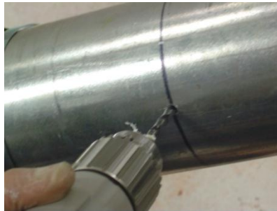
Figura 12. Instalación de piezómetros.
