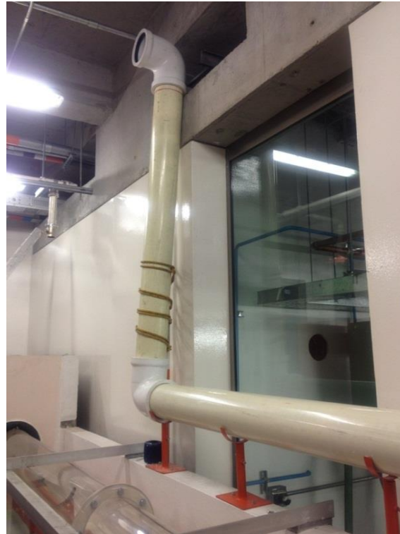
Figura 89. Tubería principal y primer tubo de desagüe acoplado (II).
