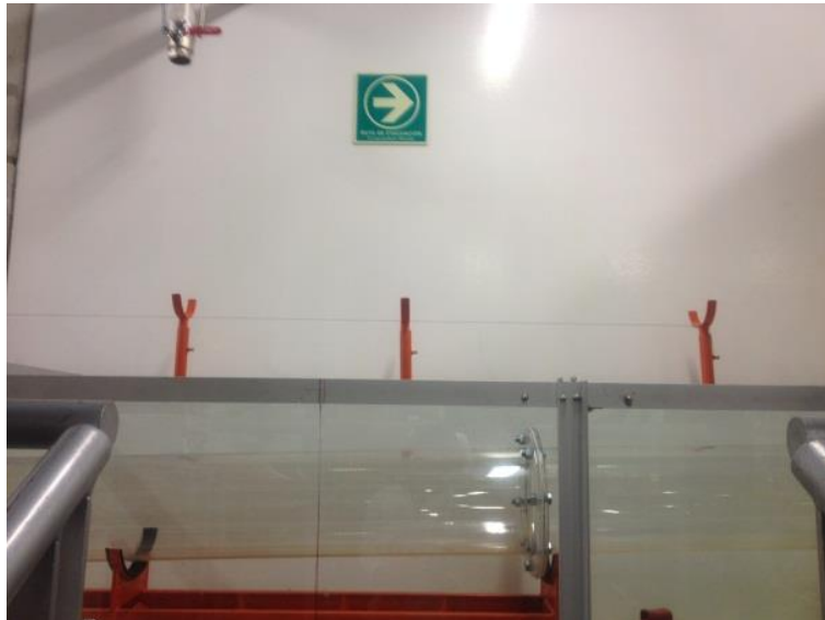
Figura 47. Cuerda instalada para nivelación de soportes.
