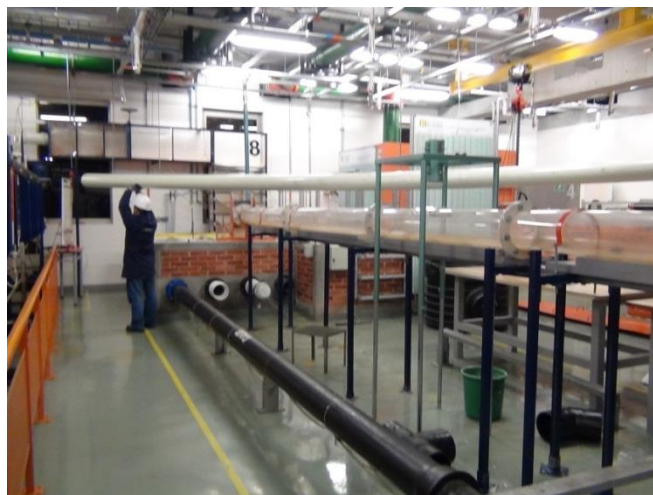
Figura 68. Ubicación de la tubería en el laboratorio (VIII).
