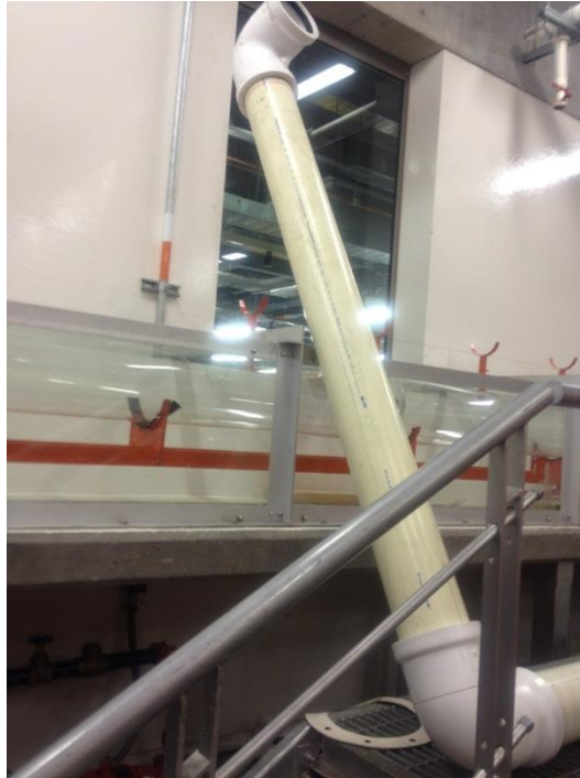
Figura 87. Acoplamiento inicial de la estructura de desagüe.
