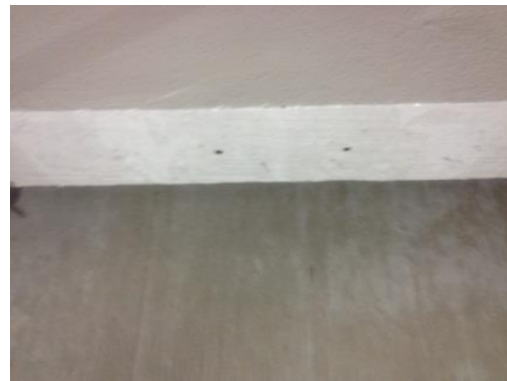
Figura 43. Instalación de los soportes.
