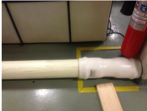
Figura 91. Acoplamiento de la unión en la estructura de desagüe.
