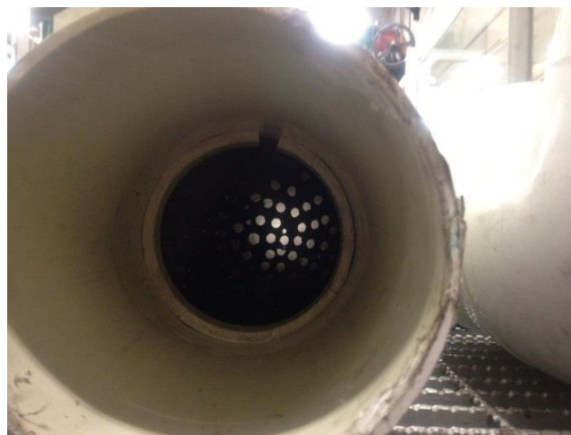
Figura 81. Instalación del segundo soporte de las rejillas uniformadoras de flujo.
