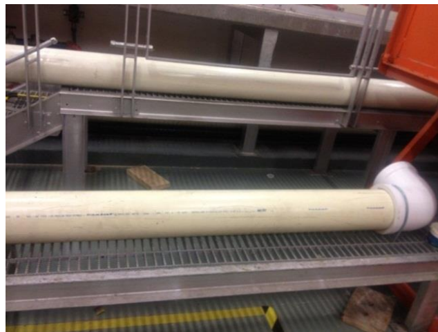
Figura 85. Acoplamiento de codos (I).
