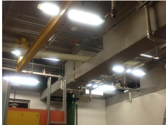
Figura 94. Instalación de estructura de desagüe (II).
