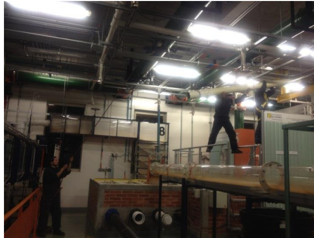
Figura 93. Instalación de estructura de desagüe (I).
