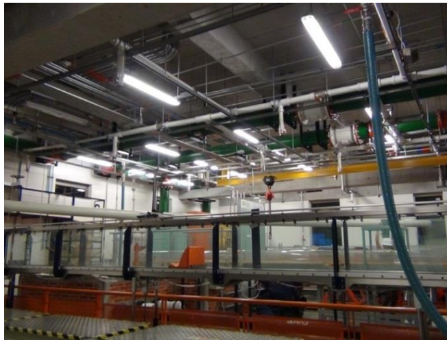
Figura 70. Ubicación de la tubería en el laboratorio (X).
