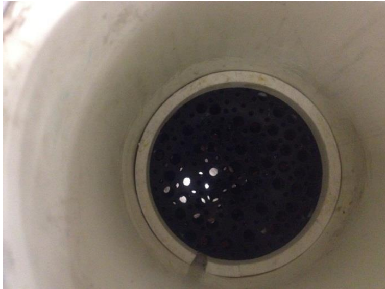
Figura 82. Instalación del tercer soporte y la segunda rejilla uniformadora de flujo
