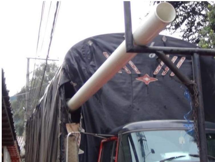
Figura 49. Transporte de la tubería principal (I).
