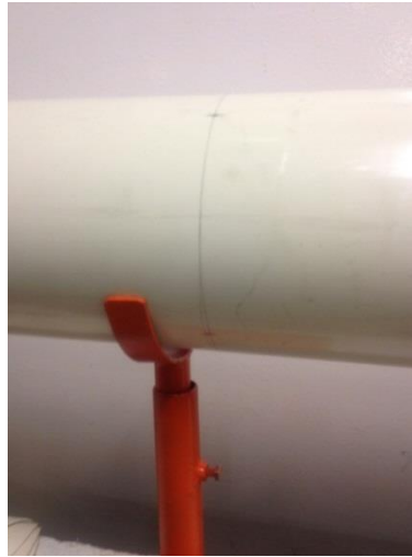
Figura 101. Localización de las mangueras para los manómetros diferenciales.
