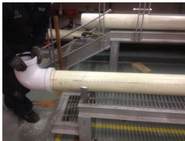
Figura 86. Acoplamiento de codos (II).
