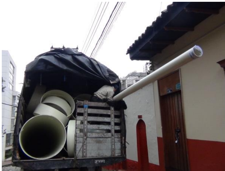
Figura 51. Transporte de la tubería principal (III).
