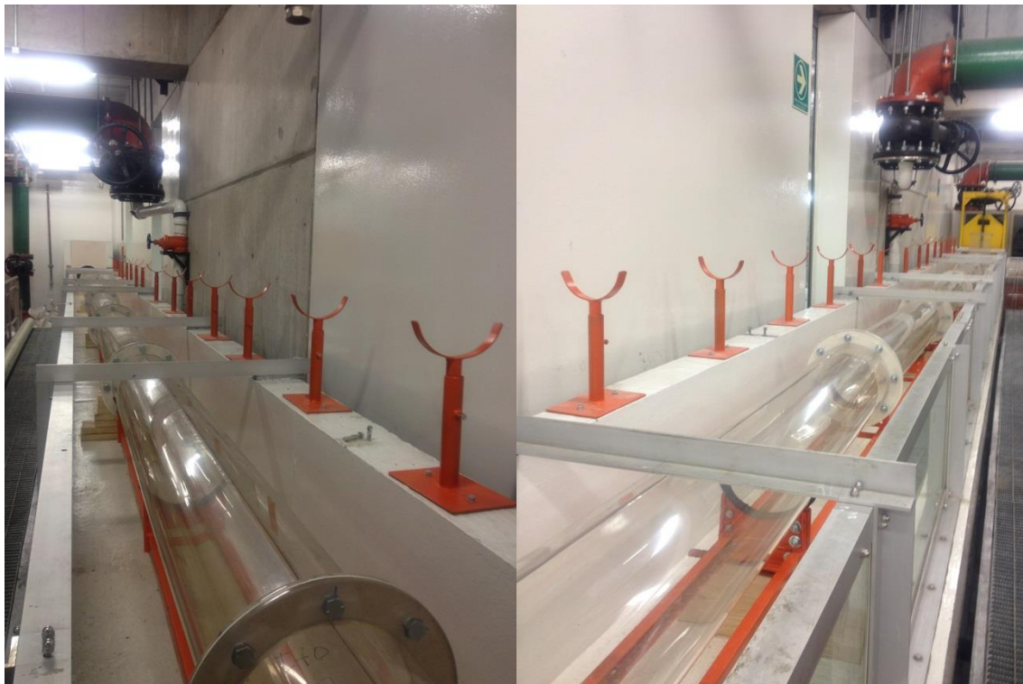
Figura 45. Vista de los soportes instalados en el sitio de ubicación del montaje.
