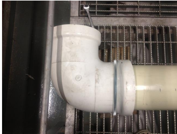
Figura 84. Amarre empleado para el acoplamiento de codos (vista superior).
