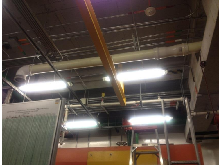
Figura 96. Tubería de desagüe acoplada.
