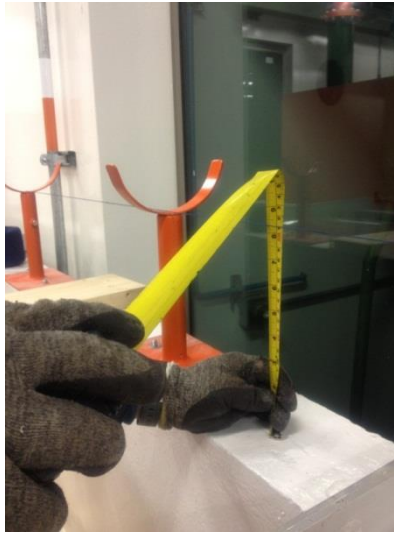
Figura 48. Nivelación de soportes.
