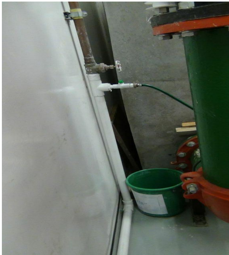
Ilustración 17. Extensión de tubería de agua potable.
