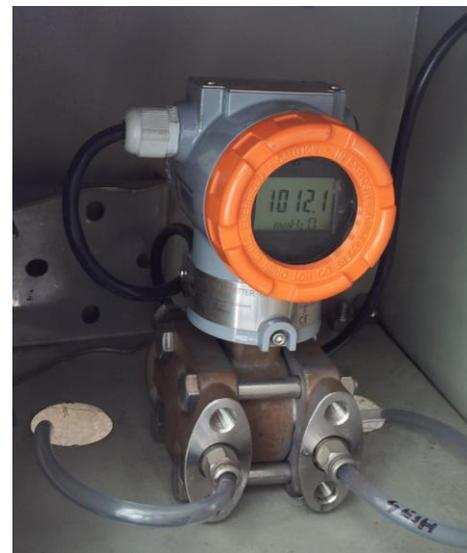
**Figura 21** Sensor de presión diferencial
