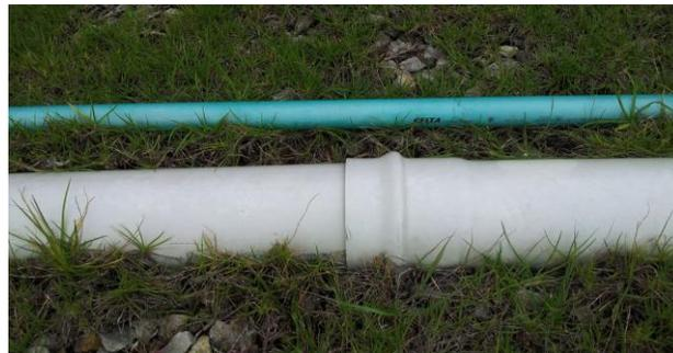
**Figura 10 Unión tubería principal**
