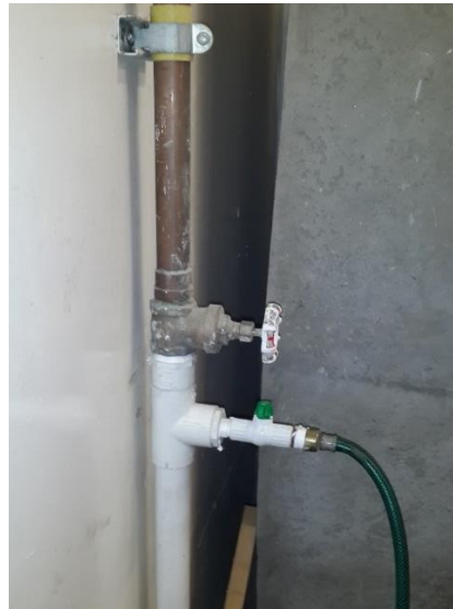
Ilustración 11. Válvula que permite el paso de agua al modelo.
