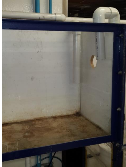
Ilustración 17. Tanque de agua clorada, previo a las modificaciones.
