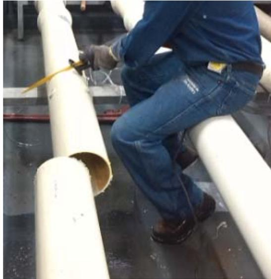
**Figura 15 "Proceso de desmonte y corte de las tuberías de PVC de 6 pulgadas".**
