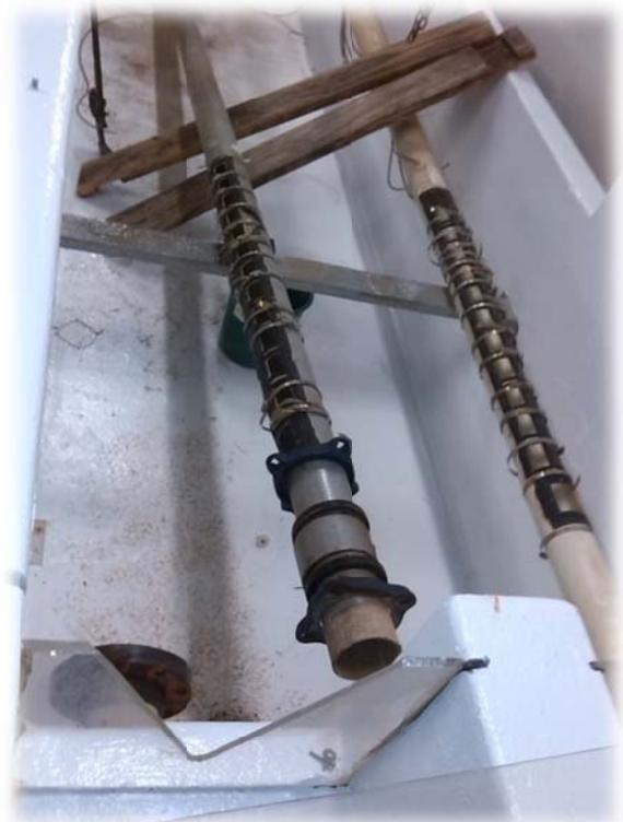
**Figura 11 "Desmonte tubería de PVC".**
