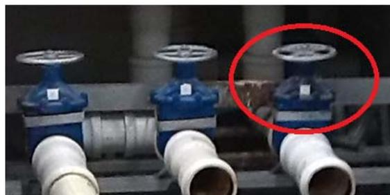
Figura 42 "Válvula tubería de Hierro Galvanizado"
