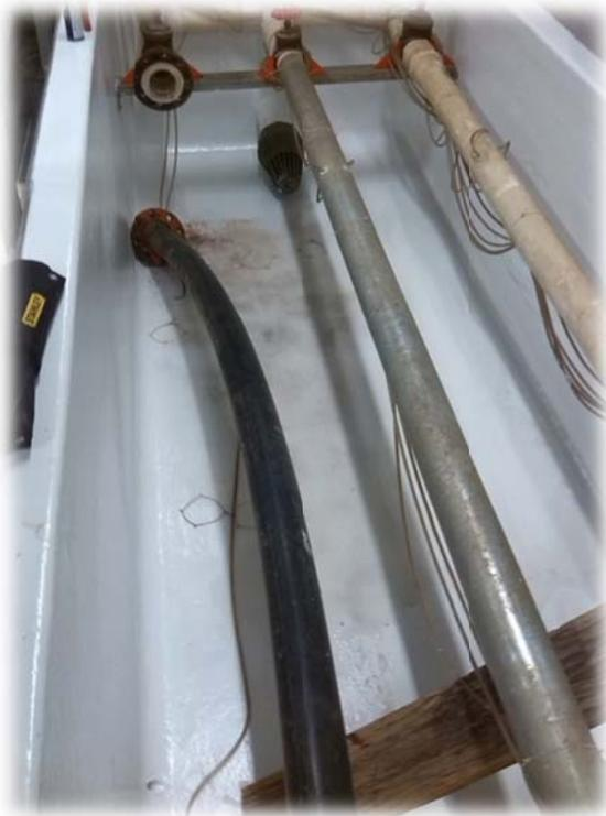
**Figura 12 "Desmonte tubería de polietileno".**
