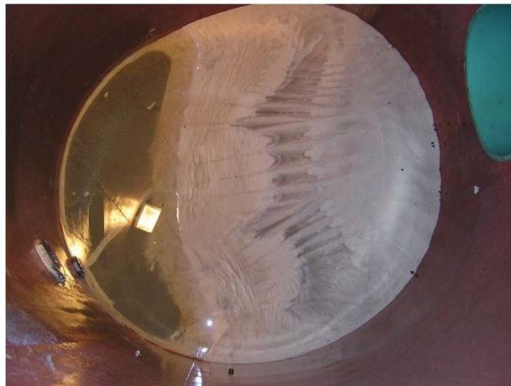
Ilustración 14 Fenómeno de erosión en el fondo del sumidero. Tomado de Adam K. Howard (2012).
