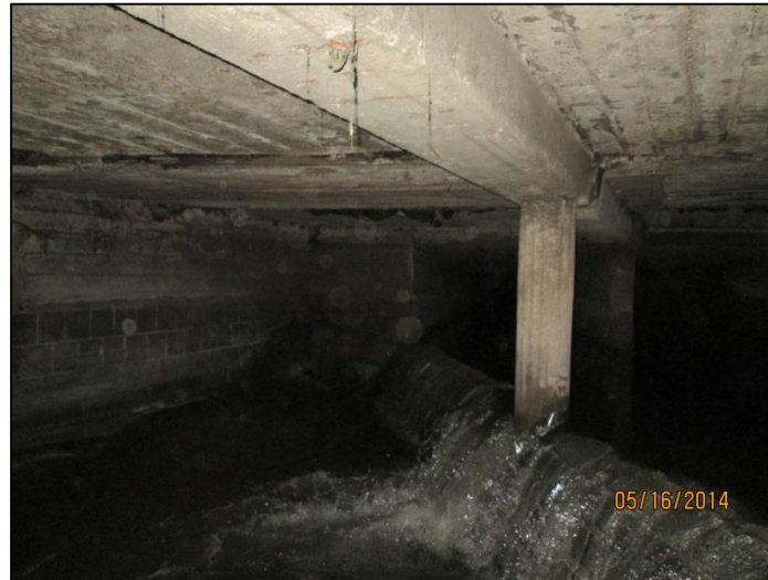
Fotografía 2.3 Estructura de alivio.
