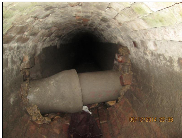
Fotografía 2.1 Tubería de concreto dentro de colector de aguas combinadas.
