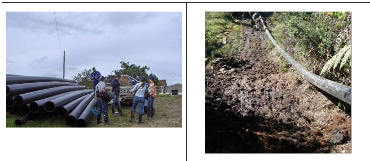
Figura 15. Registro fotográfico de instalación
