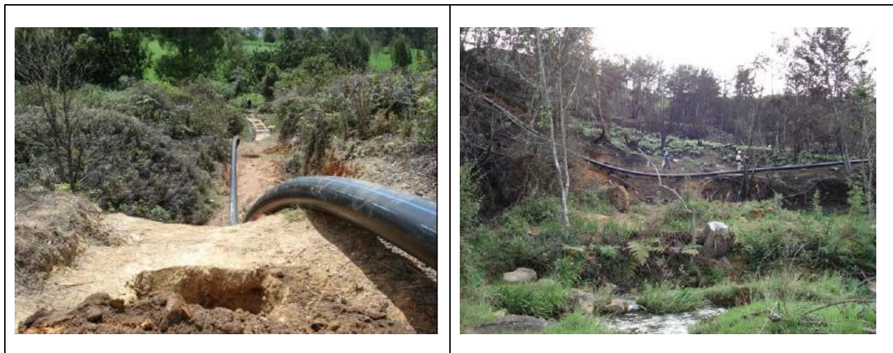
Figura 17. Registro fotográfico de instalación
