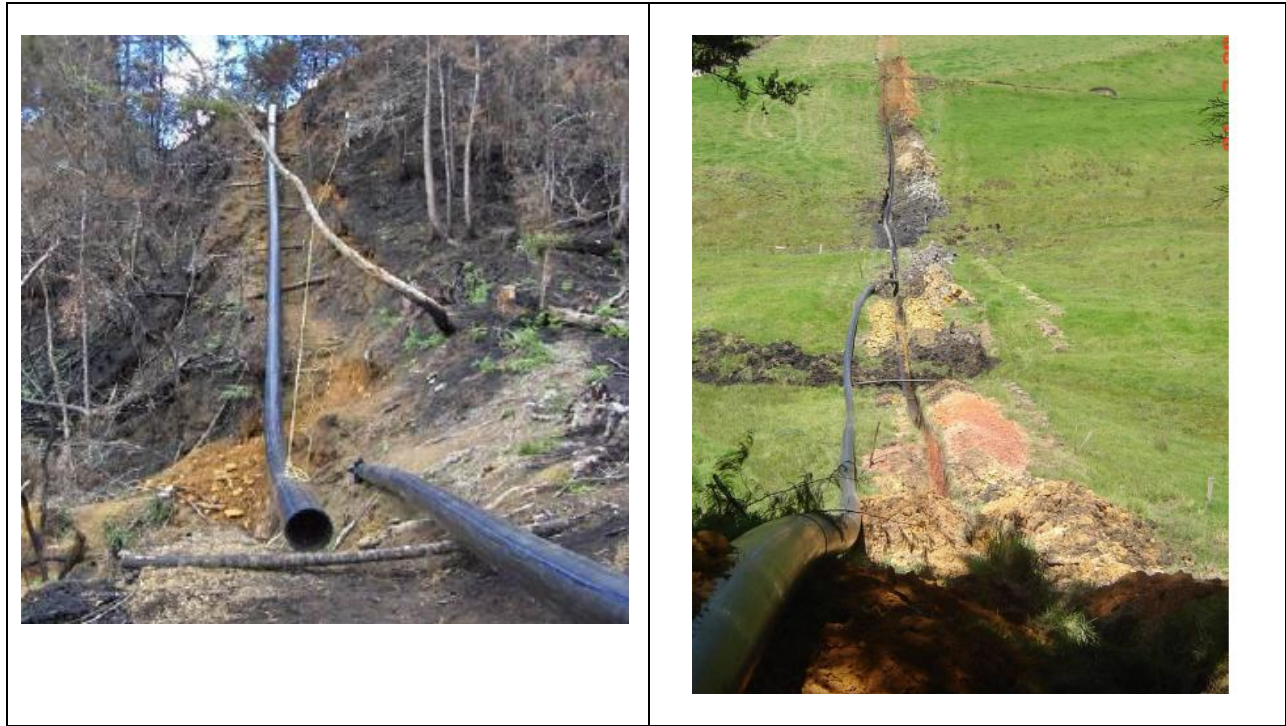
Figura 16. Registro fotográfico de instalación
