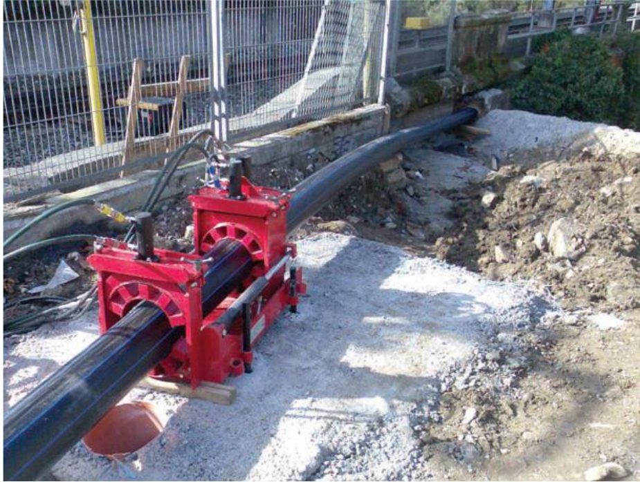
Figura 6. – Proceso de termofusion de la tubería instalada.(www.sinzatec.es).
