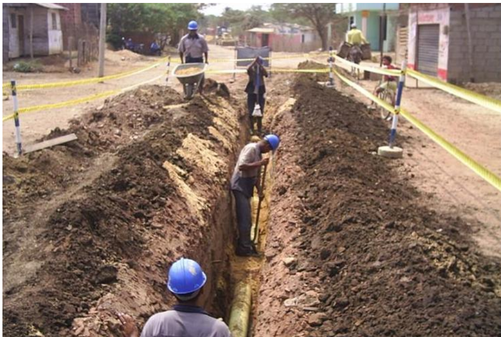
Figura 1. Instalación por medio de Zanja.
