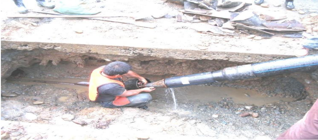
Figura 4. –Montaje de cabezote en tubería de polietileno.(Treltec Ltda).
