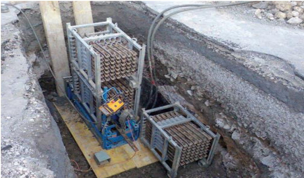
Figura 5. –Equipo de Pipe Bursting. .(www.sinzatec.es).
