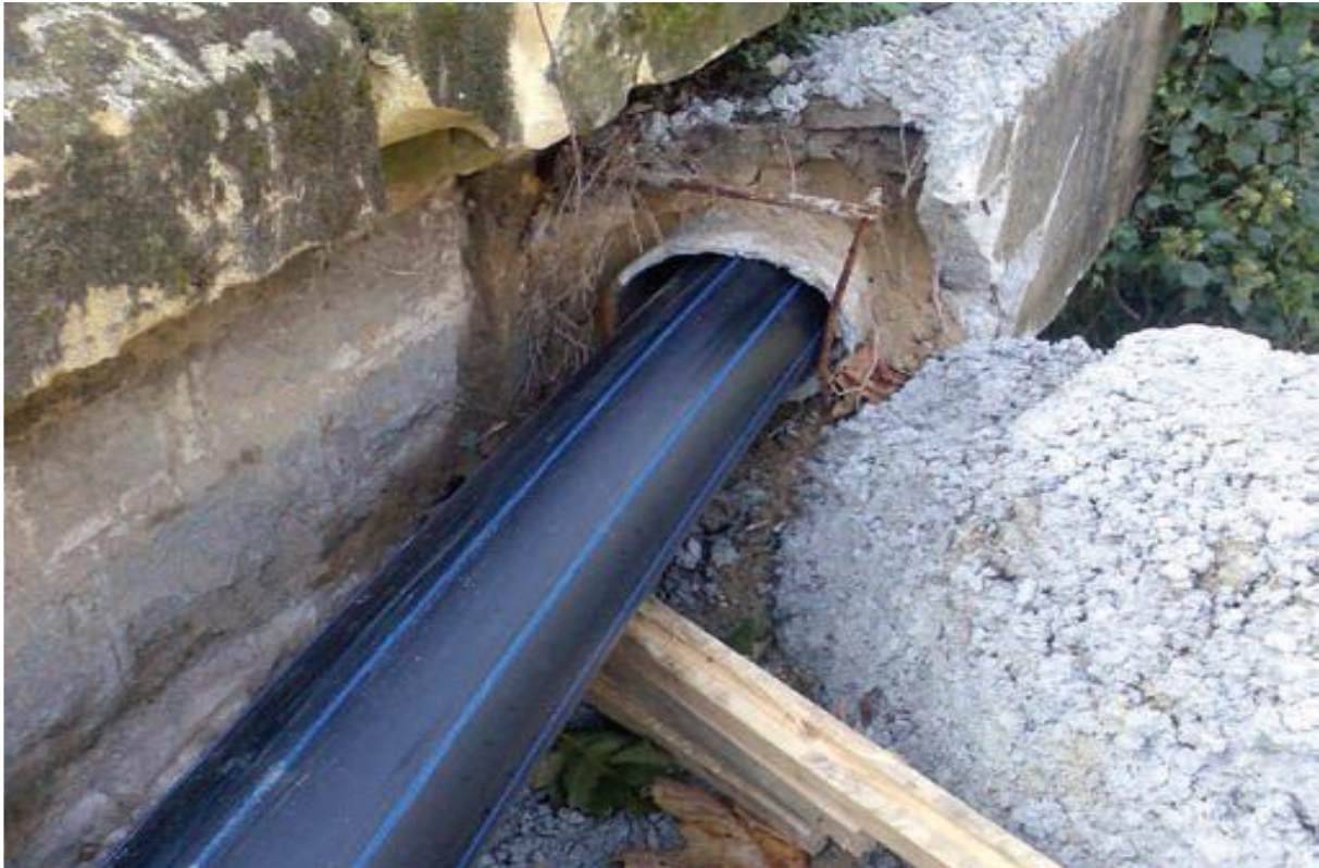
Fig. 9.- Inserción de la tubería nueva en la tubería existente( www.sinzatec.es ).
