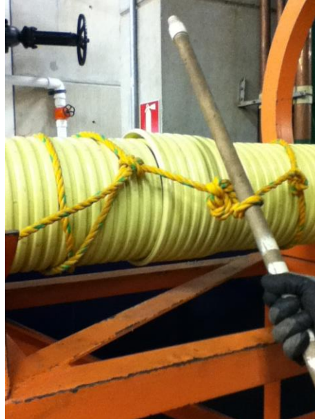
Foto 33. Unión de los tramos 1 y 2 de la tubería principal.
