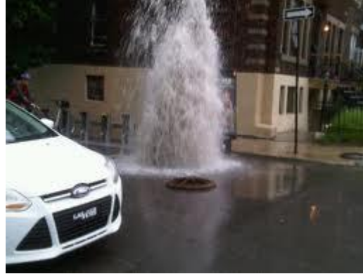
Foto 17. Géiser en alcantarillado.
