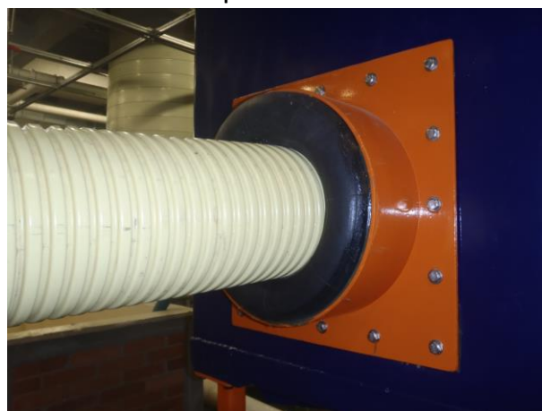
Foto 34. Conexión tubería - Tanque mediante la utilización de un neumático.
