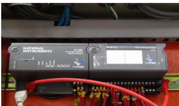
Ilustración 8 FieldPoint FP-1601 y Extensión FP-AI-111.
