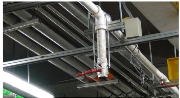
**Figura 4 Válvula de bola de la red elevada.**
