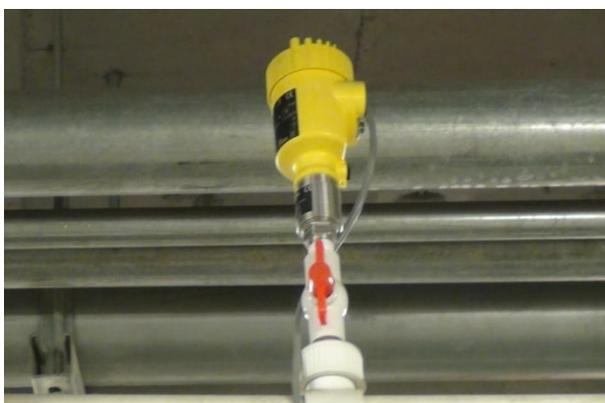
**Figura 7 Sensor de presión de la Red Elevada.**
