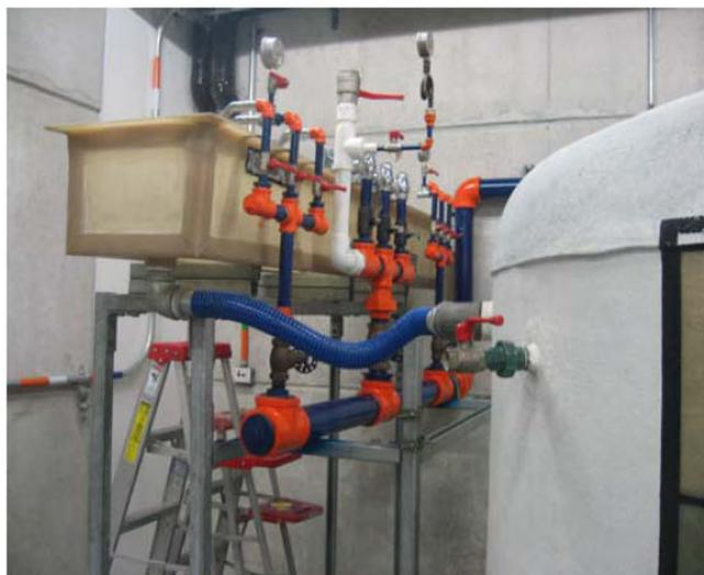
**Ilustración 4-3 Tanque de recirculación del agua**
