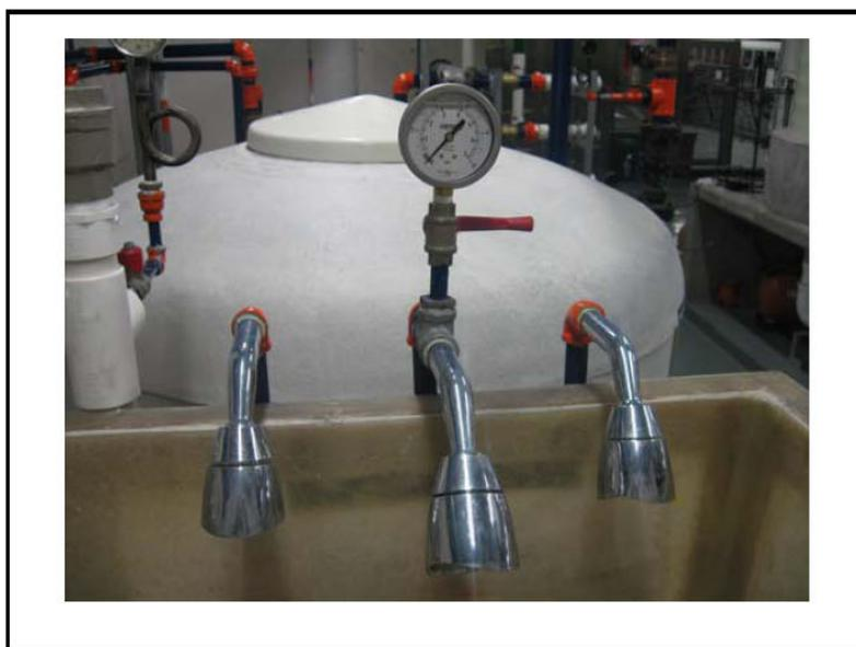
**Ilustración 5-1 Montaje de aparatos y manómetro**
