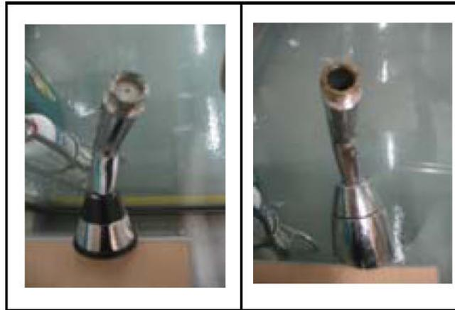
**Ilustración 8-1 Duchas con y sin dispositivo ahorrador de agua**
