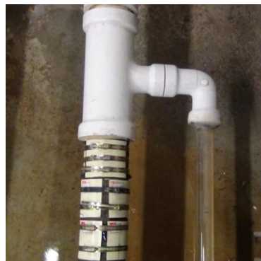
Figura 10. Conexión de los tubos de vidrio a la tubería de PVC.
