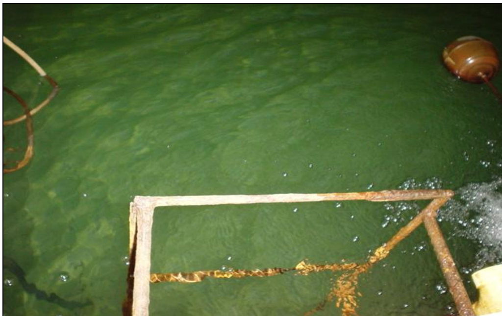
Vista 1 de la Escalera de Limpieza
