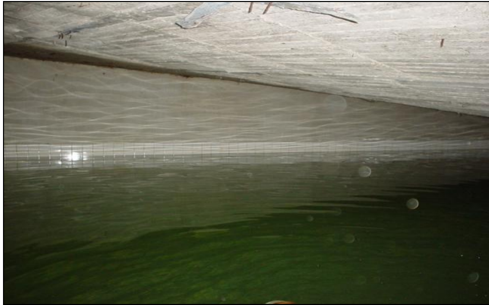
Imagen 8-6 Estancamiento del Agua por grandes tiempos de retención hidráulica
