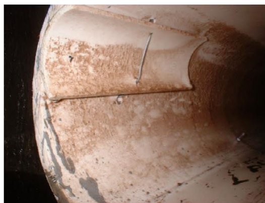
Figura 2-4. Dispositivo aguas debajo de la tubería, colonizado por biopelícula.
