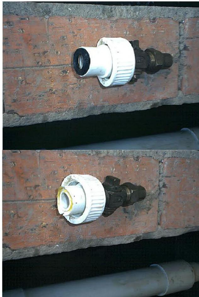
**Figura 8.8:** Detalle del acople del collar de derivación con y sin empaque hermético.
