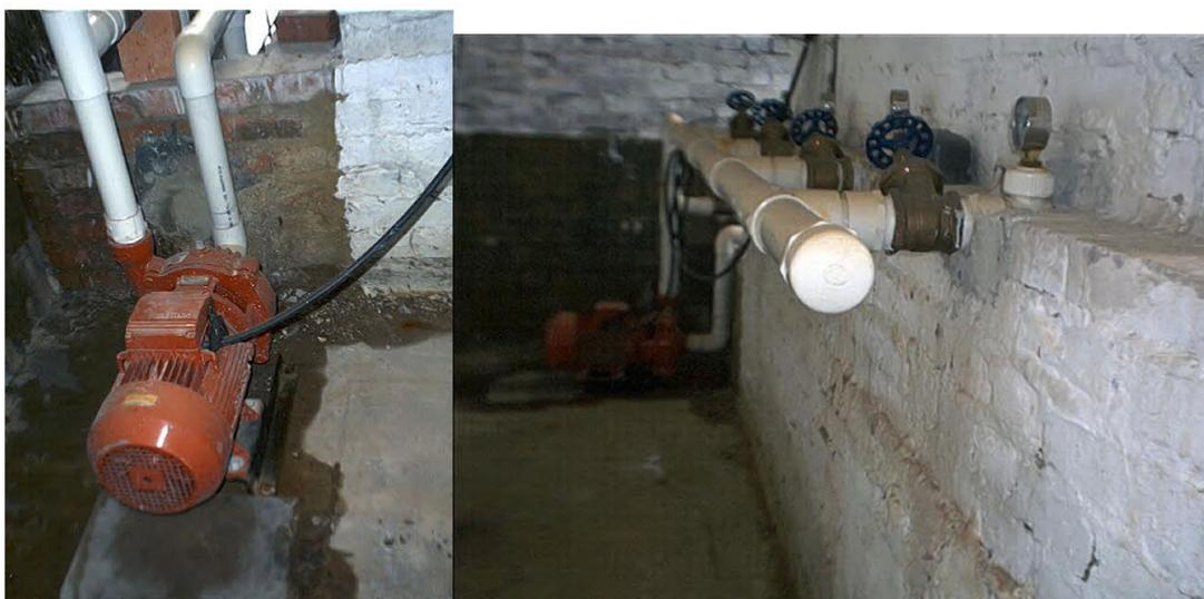
**Figura 4.1: Motobomba y sistema de distribución del circuito de pruebas.**
