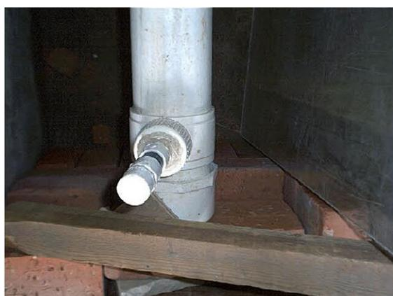
**Figura 4.4:** Sistema de purga para la evacuación del aire acumulado en la tubería fallada.
