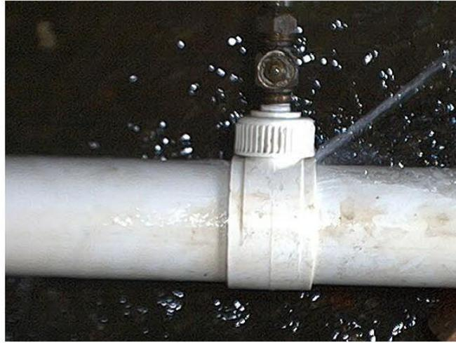
**Figura 8.7:** Fuga a través de un collar de derivación corrido sin empaque.
