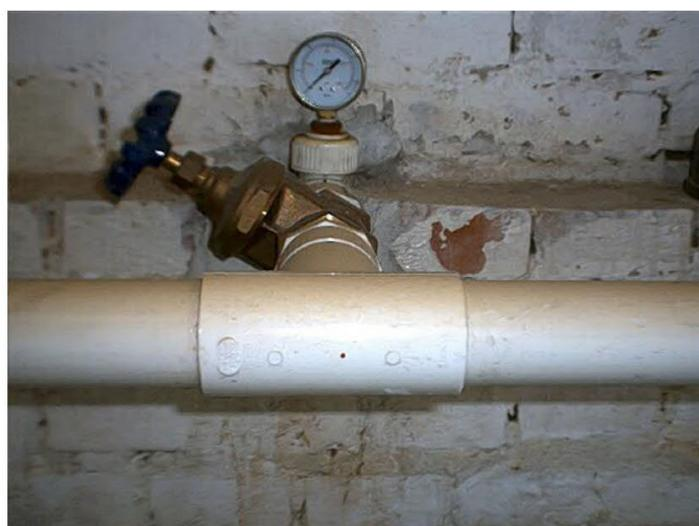
**Figura 4.2: Válvulas y manómetros ubicados en la entrada de cada canal.**
