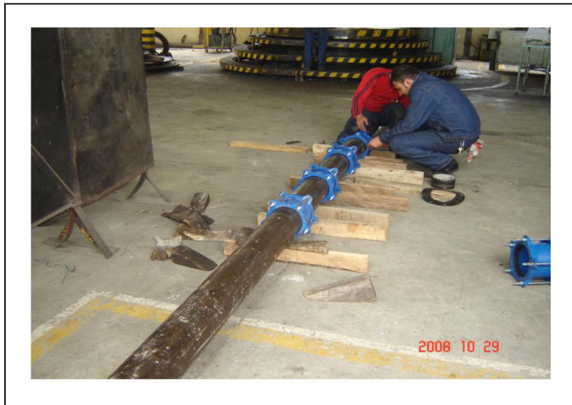
Figura 50. Construcción de testigos CCP
