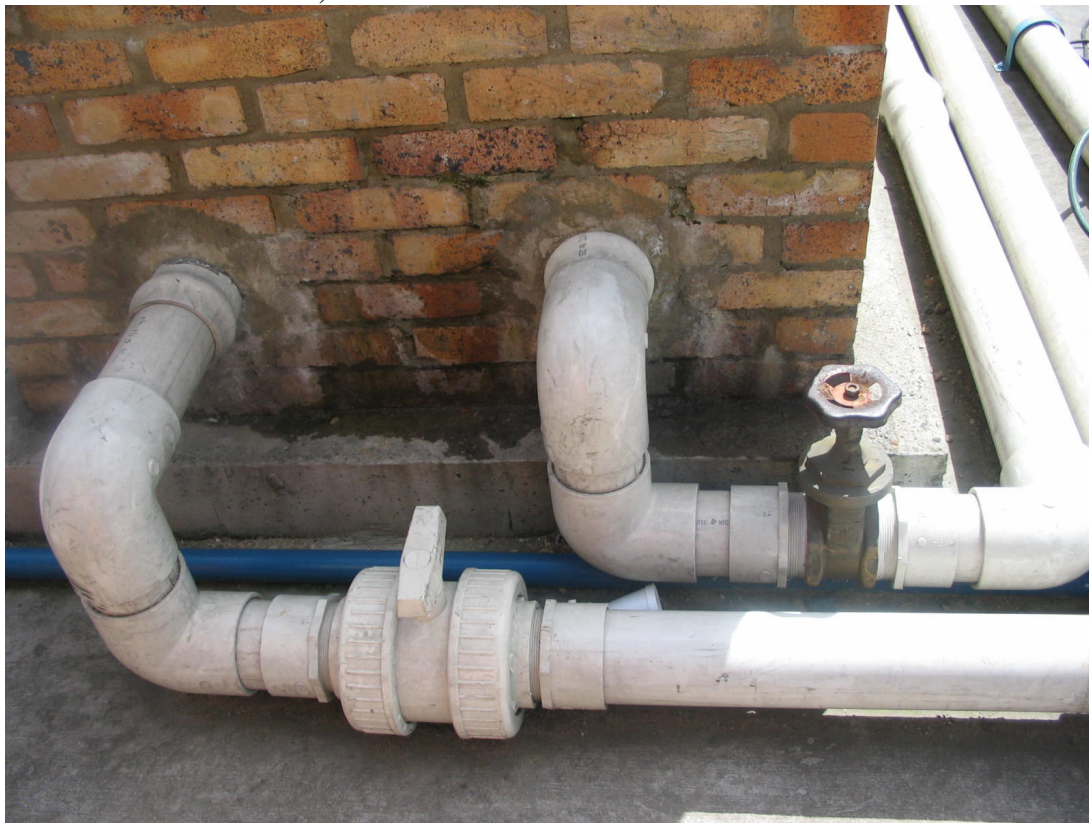
c) Unión típica campana espigo dentro del montaje.
