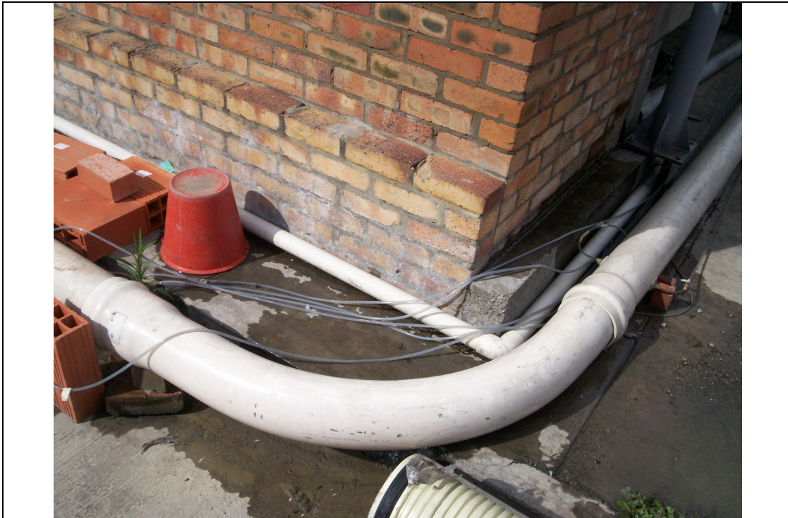
Figura 2-3 Fotos de algunas tuberías y accesorios analizados.
