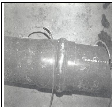
Figura 6-5 Detalle unión Z de 8"
