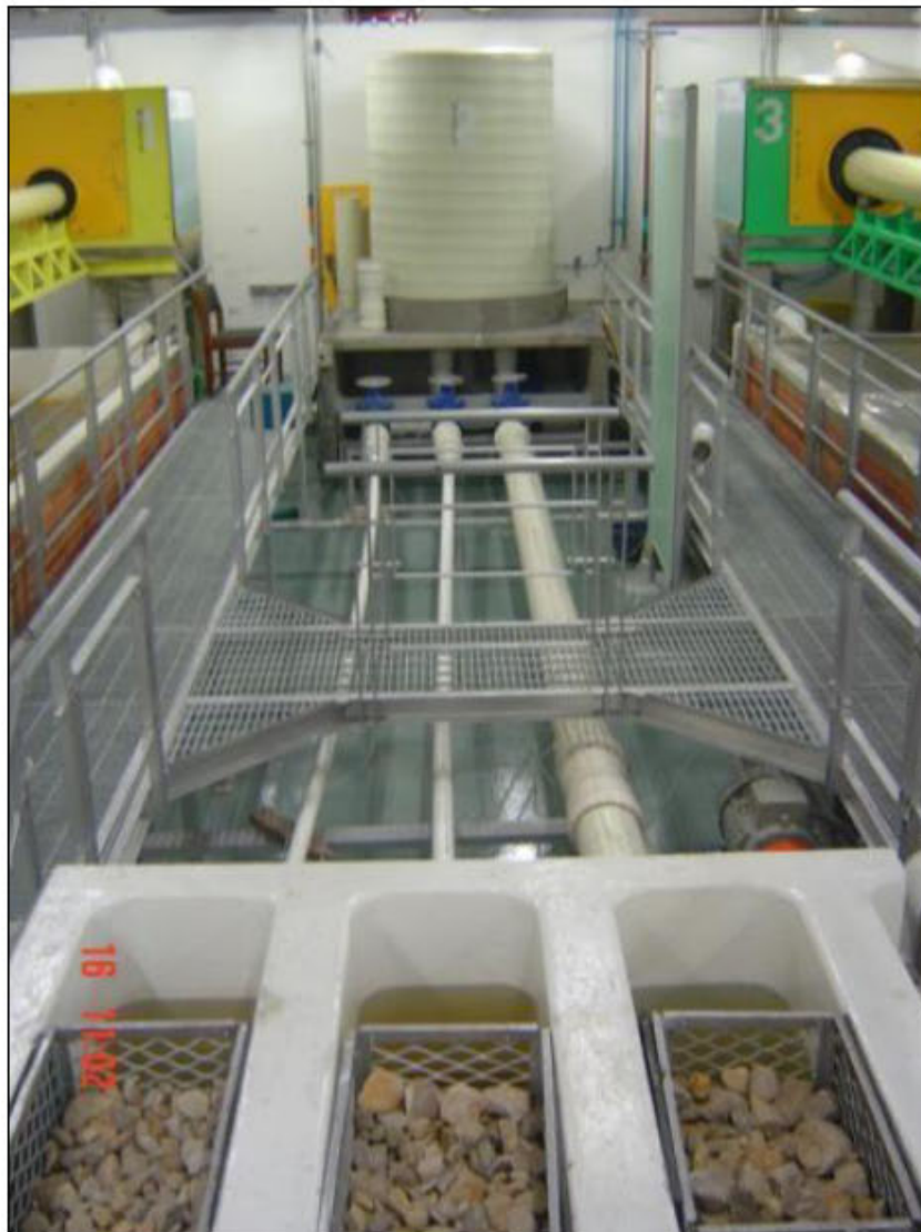
Figura 2-3. Vista general del montaje.
