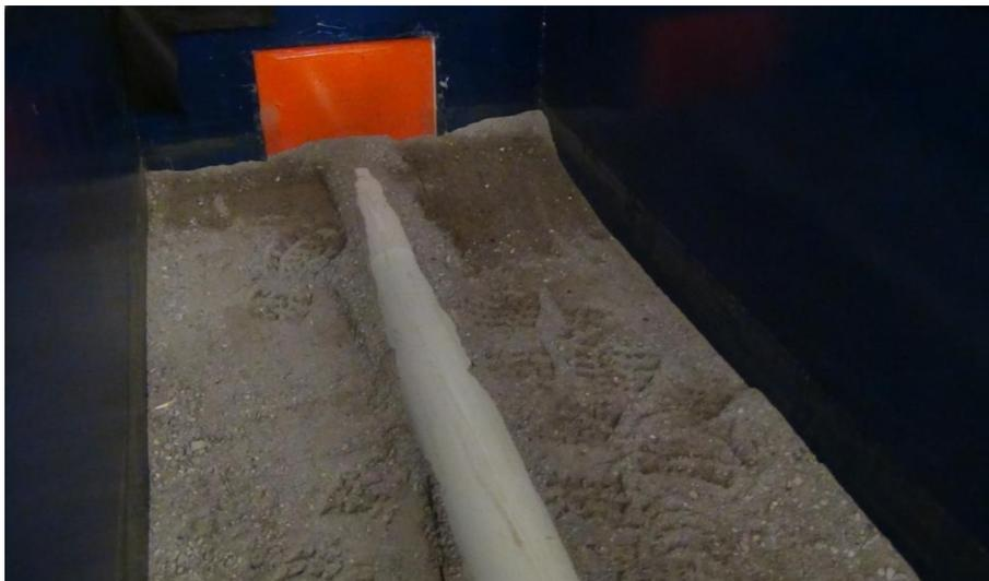
**Figura 3-26. Proceso de llenado y compactación antes de cubrir la tubería.**
