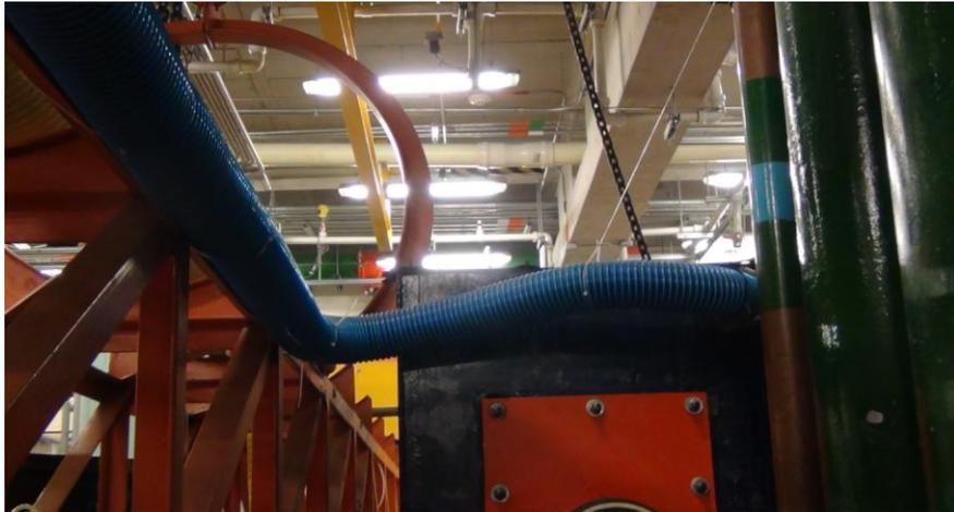
**Figura 3-14. Conexión de salida del agua entre el tanque y la manguera de plástico.**
