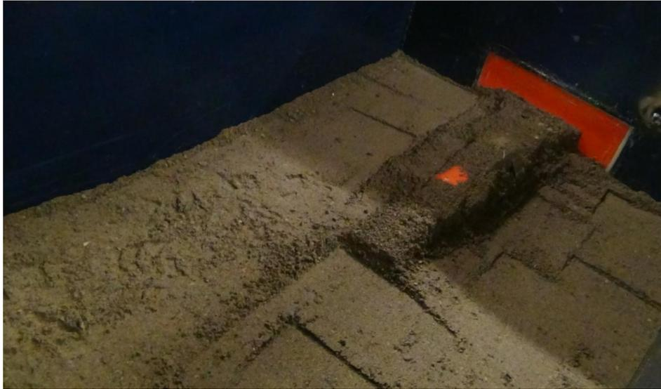
**Figura 3-27. Proceso de llenado y compactación antes de cubrir totalmente la flauta.**
