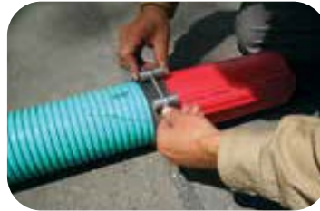
7. Instale y apriete la abrazadera en la transición
