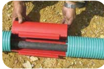
5. Ensamble la sección media superior
