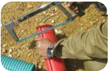
3. Corte 3 cm del ensamble mecánico a los extremos de la sección de reparaducto
