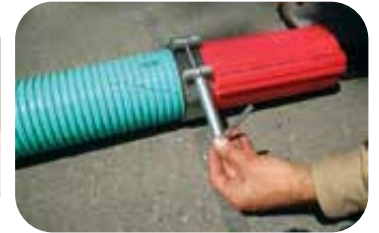
7. Instale y apriete la abrazadera en la transición
