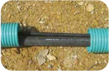
1. Corte la sección dañada
