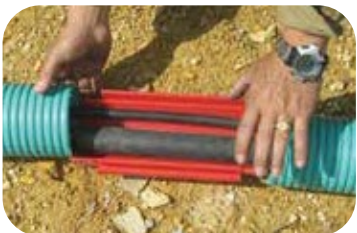
4. Coloque la sección media inferior alojando los cables
