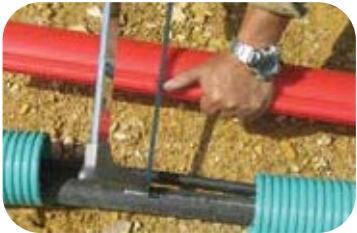
2. Corte el tramo de reparaducto para la sección dañada
