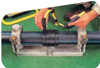
2. Dé energía a la unidad de control mediante el botón correspondiente.
