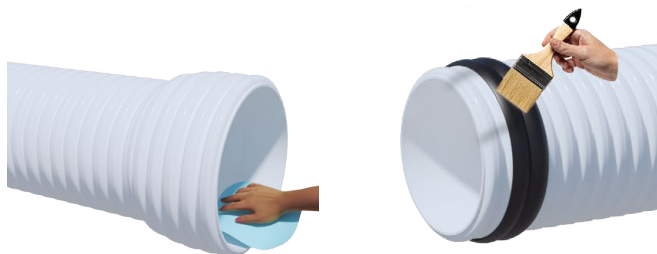
Figura 6.6. Colocación de Lubricante
