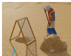
Figura 6.9. Cuidados en la selección del suelo del relleno inicial
