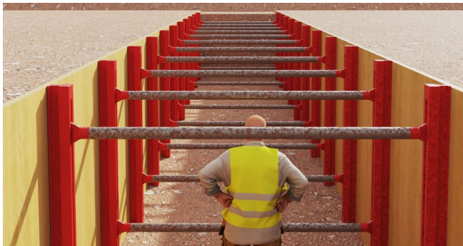
Figura 6.1. Entibado de la zanja
