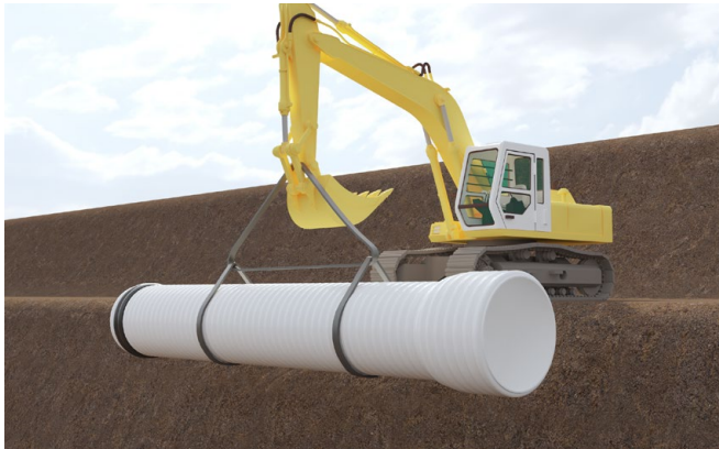
Figura 6.2. Manipulación en zanja
