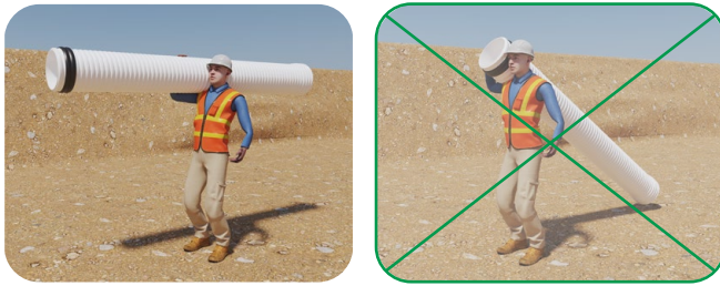
Figura 5.7. No arrastrar las tuberías
