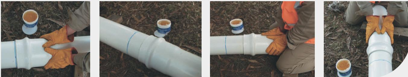
La Tubería BIAXIAL® de PAVCO WAVIN puede ser ensamblada en el borde de la zanja y luego instalada en el fondo como se muestra en las siguientes imágenes.
