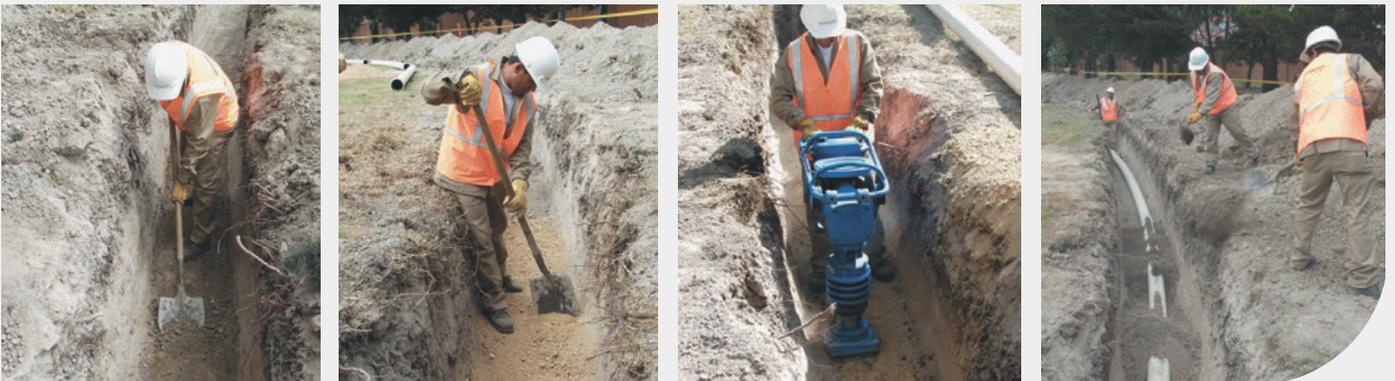
Los materiales adecuados para el encamado pueden ser triturado de roca (angular), tamaño máximo de 3/4", canto rodado, tamaño máximo 1.1/2", arena lavada, arenilla, recebo fino o material proveniente de la excavación si es apropiado. Su selección dependerá de la disponibilidad local y de la presencia o no de nivel freático, caso en el cual debe usarse el primero.
